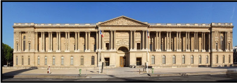
Anexo 1.11: Fachada Oriental del Palacio del Louvre, Paris
