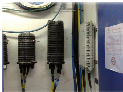
Figura 1.4 – Distintos tipos de ROM (Repartidos Óptico Modular)
