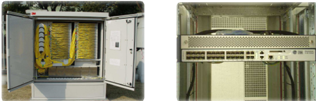
Figura 1.3 – Armario de calle (izq.) y concentrador óptico (dcha.)
