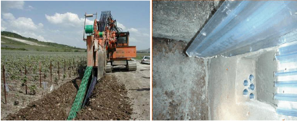
Figura 1.44. – Obra pública mecanizada e instalación de fibra bajo tierra.
