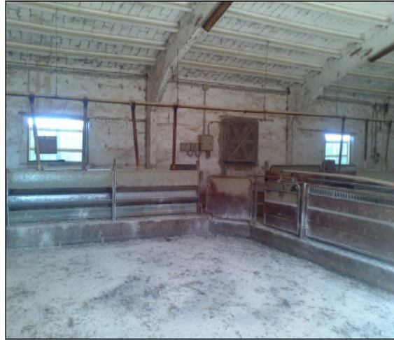
Figura 2. Situación inicial de la nave de ensayo.
