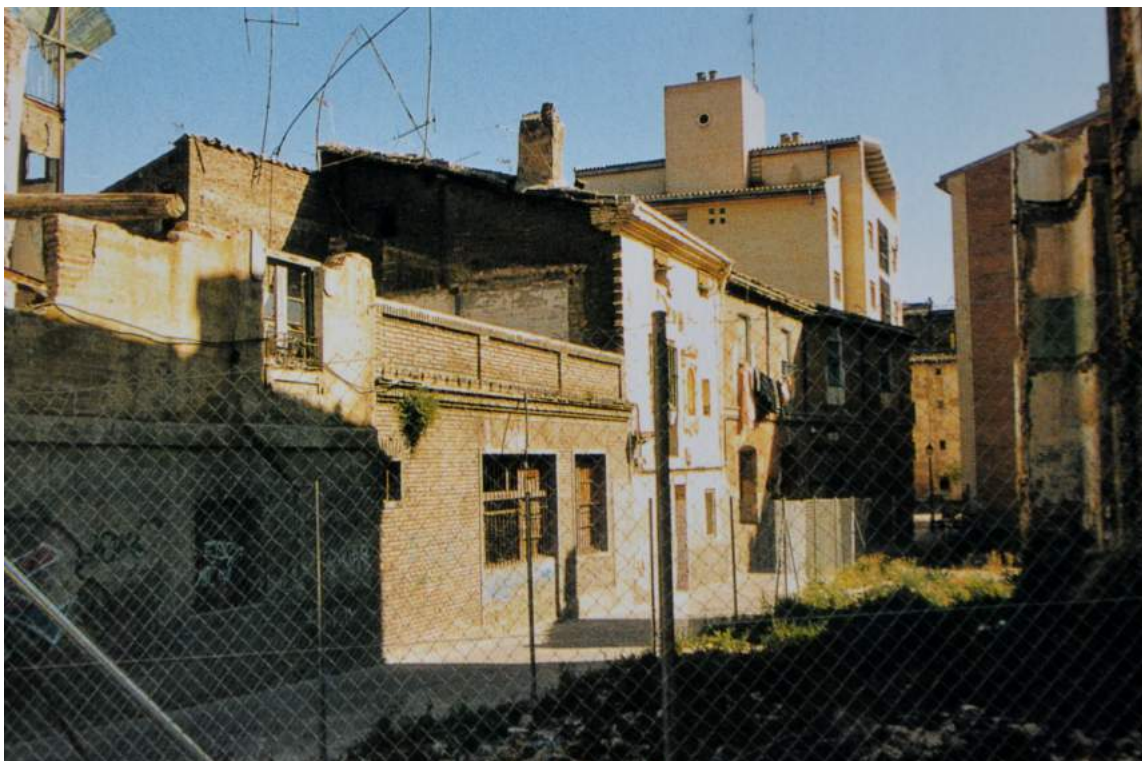
Figura 17 - Solares en la Calle Olleta en 1996. Fuente: PICH 1996
