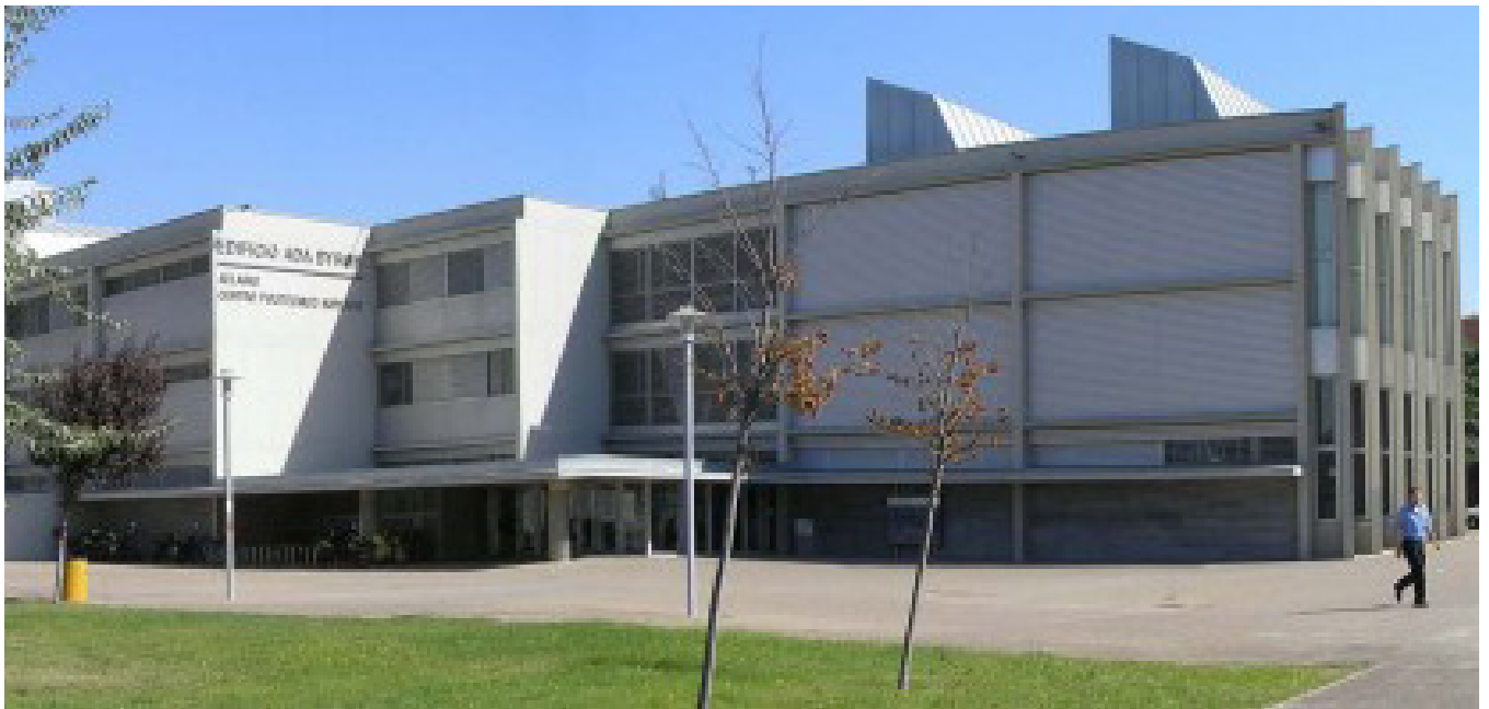
Figura 39. Exterior del Ada Byron
