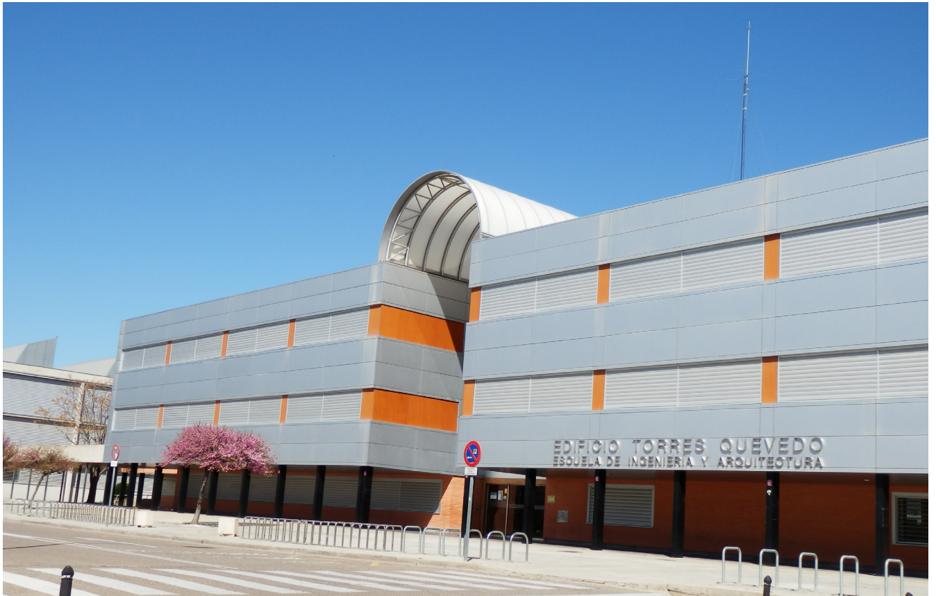
Figura 33. Exterior del edificio Torres Quevedo
