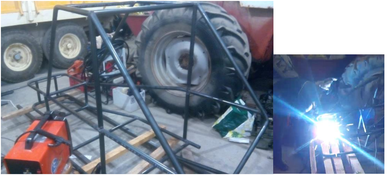
Figura 86: Punteo de la estructura
