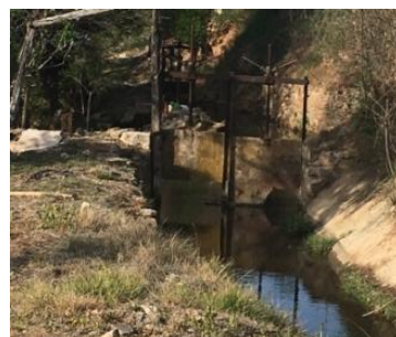
FOTO 3: Parte inicial de la obra de toma y aliviadero (izquierda), final de la obra de toma en las compuertas para el agua sobrante (derecha inferior), agua sobrante (derecha superior).
