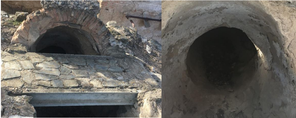
FOTO 5: Cámara de carga y principio de tubería forzada (izquierda), interior de la tubería (derecha).
