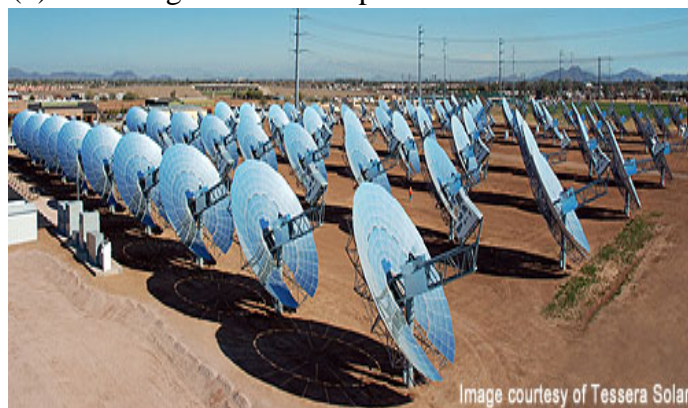
Fig. 8 Instalación de discos Stirling en Arizona con una potencia de 1,5 MW. (9)
