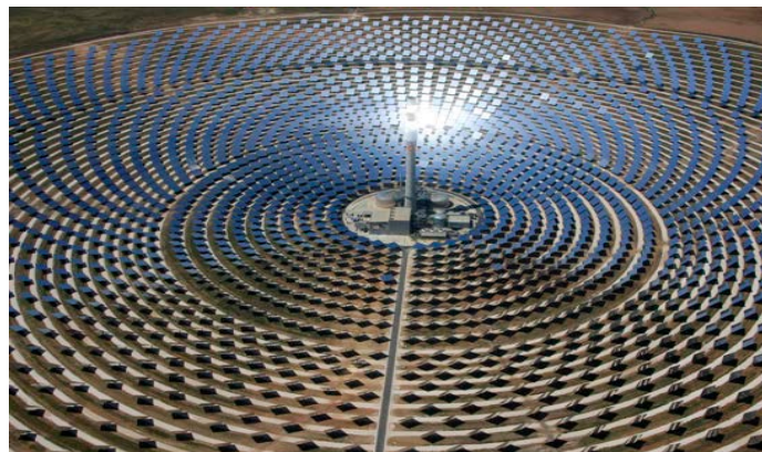
Fig. 7 Central Torre, Gemasolar, de 19,9 MW situada en Sevilla, España (8)
