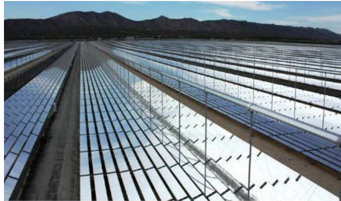
Fig. 4 Central termo-solar lineal Fresnel Puerto Errado 2 de 30 MW en Murcia. (5)
