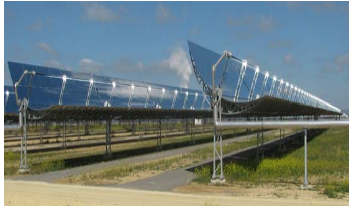
Fig. 6 Planta solar de captadores cilindro-parabólicos, Valle 1 y 2 situada en Cádiz, España. (6)
