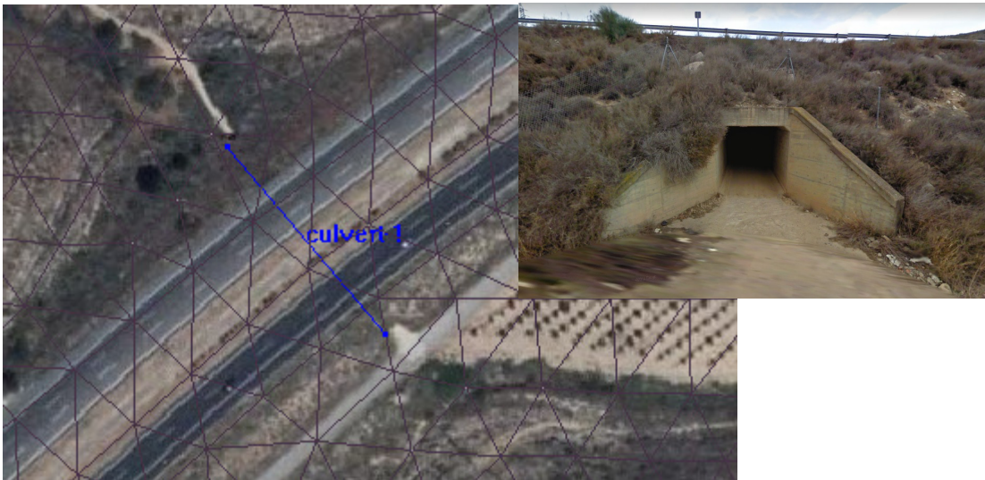
FIGURA 10. Obra de drenaje en la AP 2
