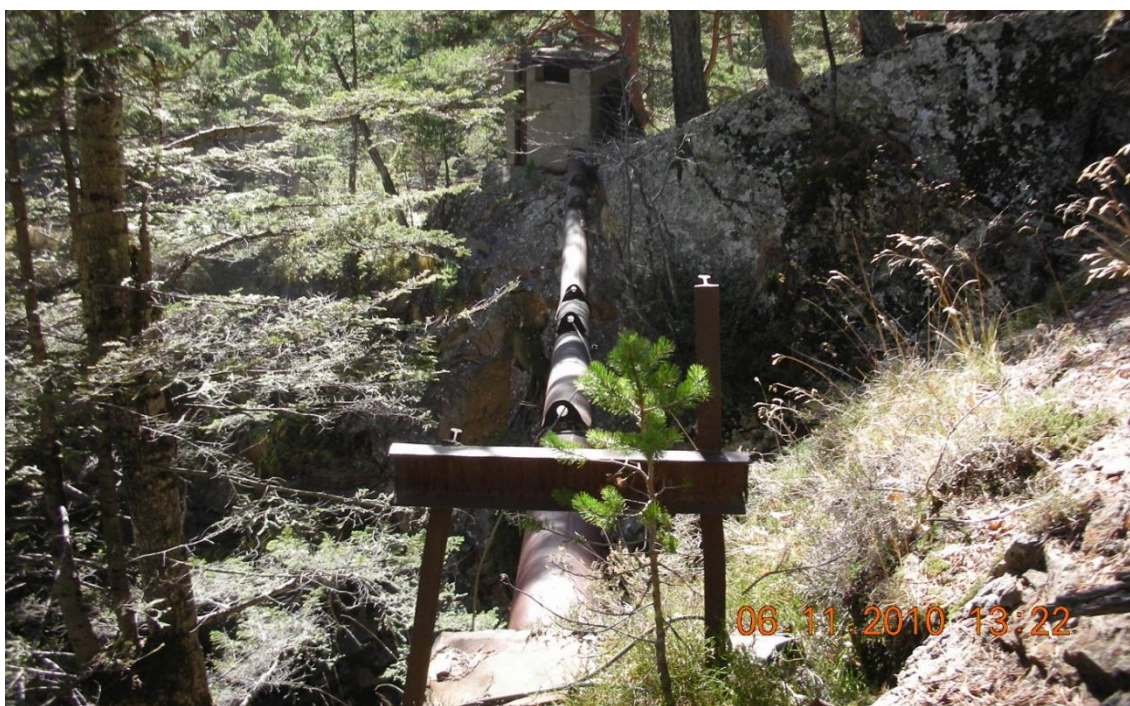
Ilustración 18. Tramo final en vuelo de tubería derivación.
