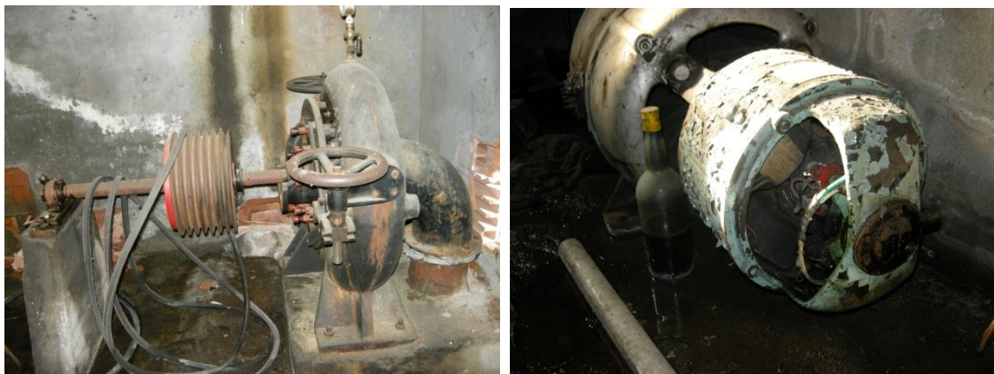
Ilustración 22. Turbina Francis y generador trifásico.
