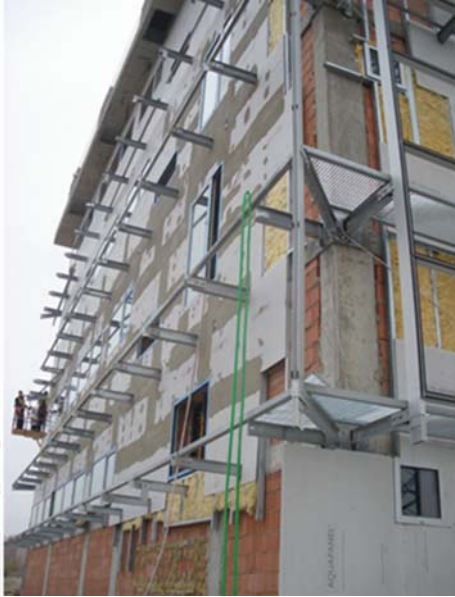
Imagen 1. Edificio con el aislamiento colocado de ventana recién colocada
