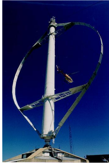
Figura: 8.3; Aerogenerador tipo Darrieux.
