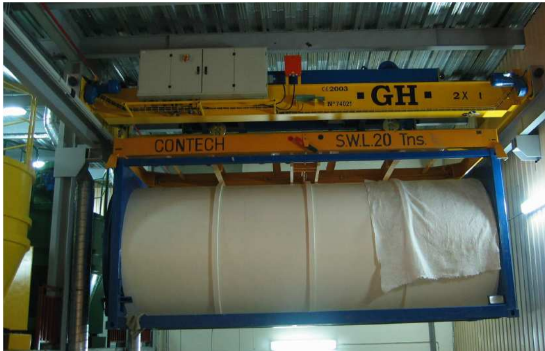
30. Elevación del contenedor mediante puente-Grúa con Spreader [30]
