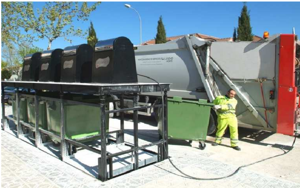
13. Contenedores soterrados de carga trasera [15]
