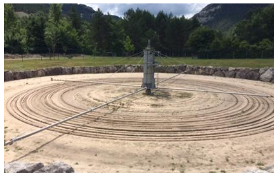
Figura 2.7: Filtro intermitente de arena
