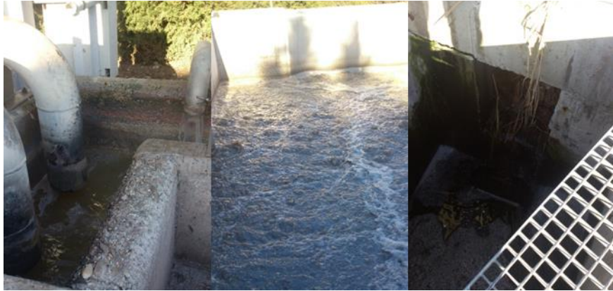
Figura 4.32: Imágenes de algunos puntos de muestreo. a) Entrada (M1); b) Reactor aerobio (M3); c) Efluente (M8)
