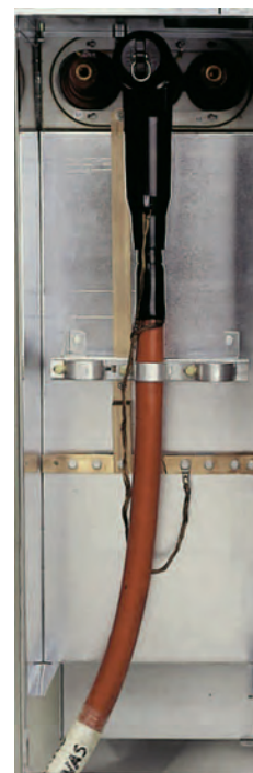
Detalle conexión. Borna en T EUROMOLD (K-400TB) atornillable
