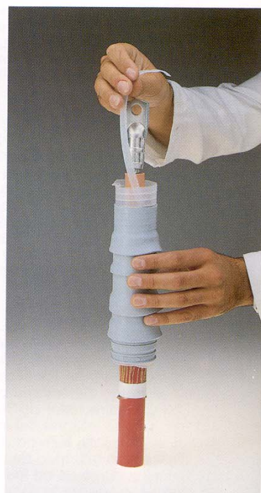
2°. Posicionar el QTII sobre el cable.
