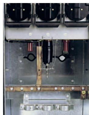
Detalle conexión. Borna acodada EUROMOLD (K-158LR) enchufable
