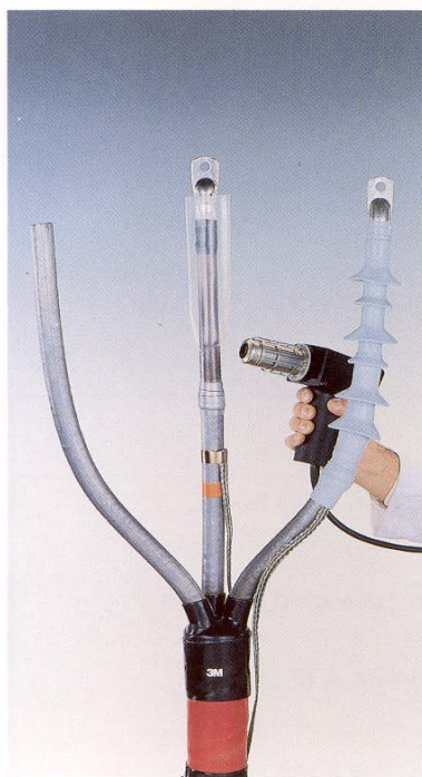
3°. Aplicar tubo termorretractil.
