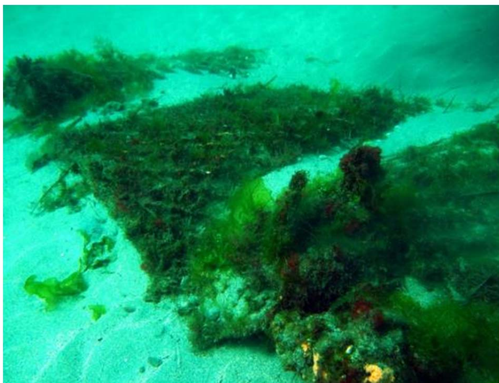
Se puede apreciar un pequeño tramo expuesto de la malla tridimensional, con los organismos adherentes que favorecen la sedimentación. Fot: MSC
