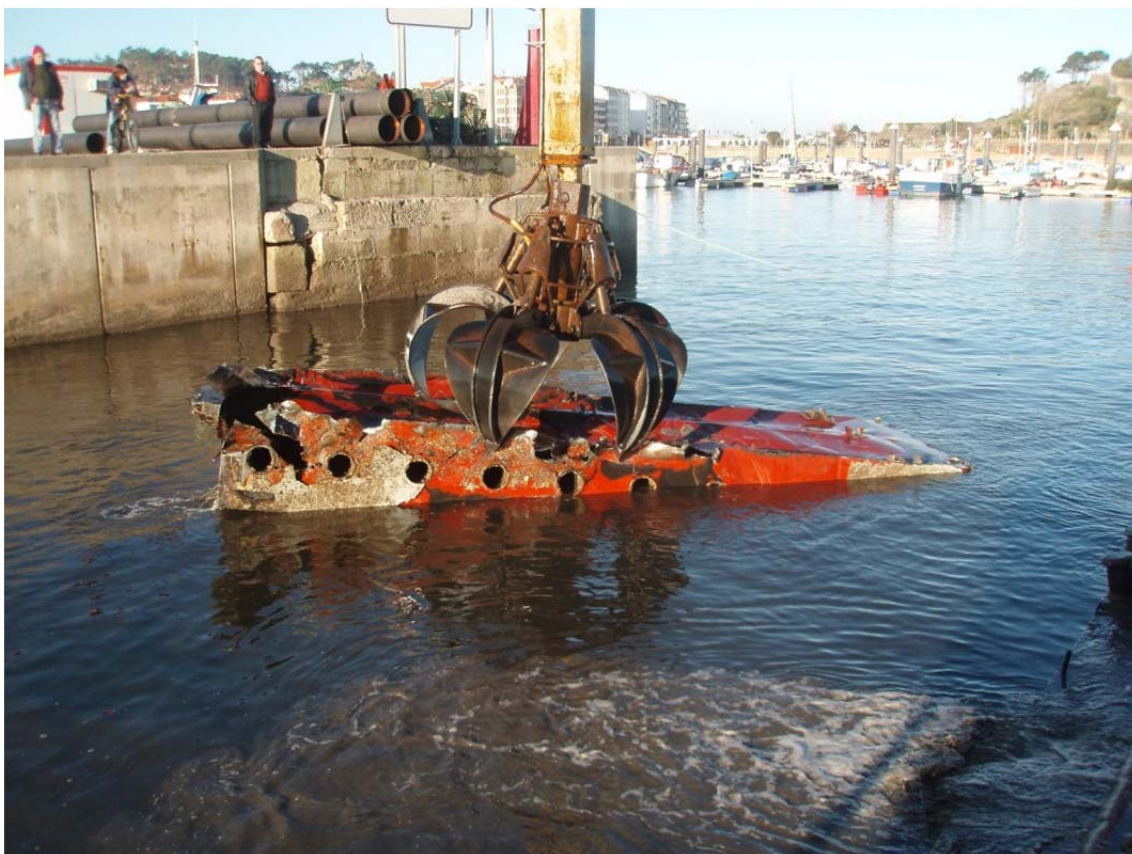
Retirada de un módulo de acero de un pantalán, uno de los muchos obstáculos que impedían la excavación manual del sedimento en el puerto de Baiona. Fot: MSC.
