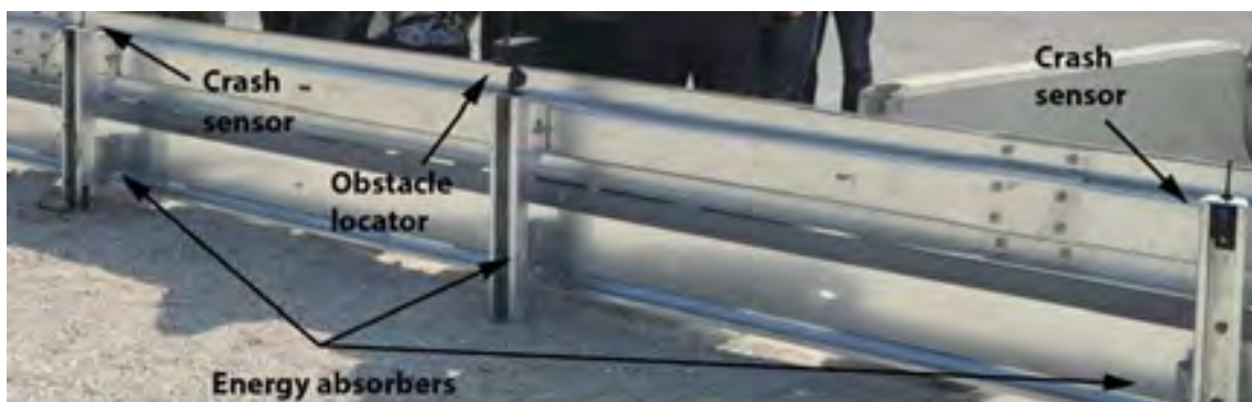
Figura B.1: Modelo de la barrera inteligente Smart RRS
