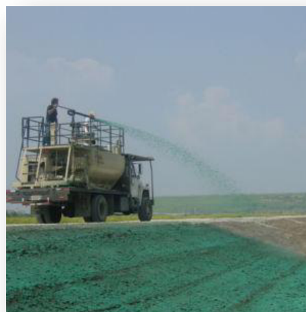
11. Hidrosembrado de manta orgánica en talud . 25 -
