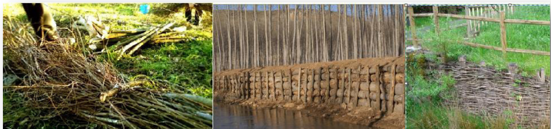
9. Fajina, entramado y trenzado (de izquierda a derecha)
