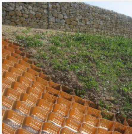
13. Instalación de geoceldas
