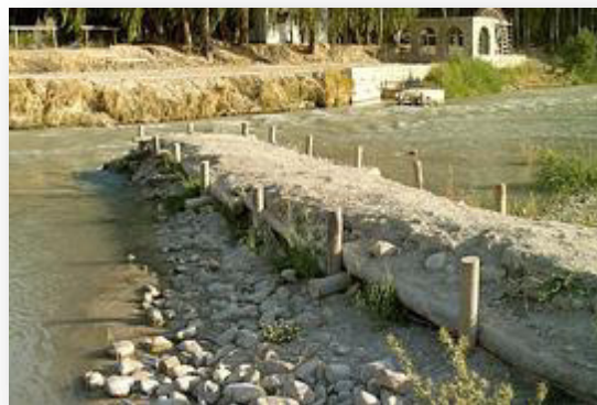
26. Deflector creado con murete vegetado
