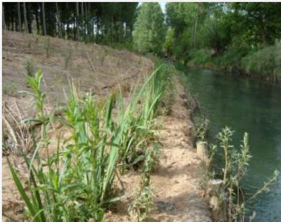
25. Empalizado vivo con estaquillado de taludes en el río Piedra
