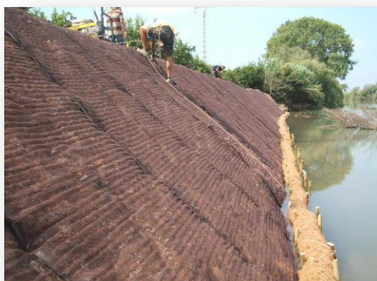
12. Recubrimiento de talud con geomalla para su posterior siembra
