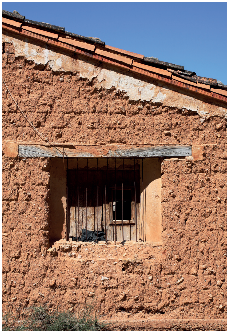
Fig. 28 Construcción de ladrillos de adobe, ya sin enfoscado, 2017.
