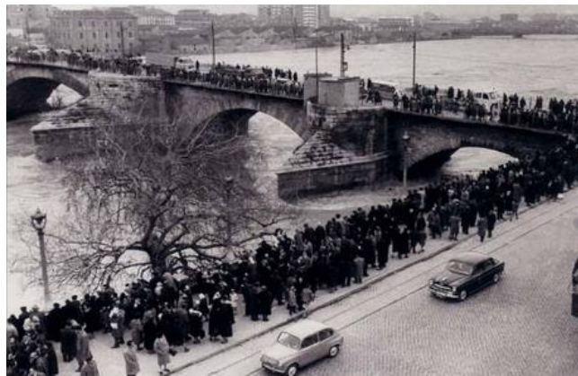
Figura D.2: Imagen de la inundación de 1961 a su paso por el puente de Piedra en Zaragoza. [13]
