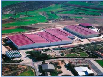
Figura 31. Vista aérea fabrica DS Smith
