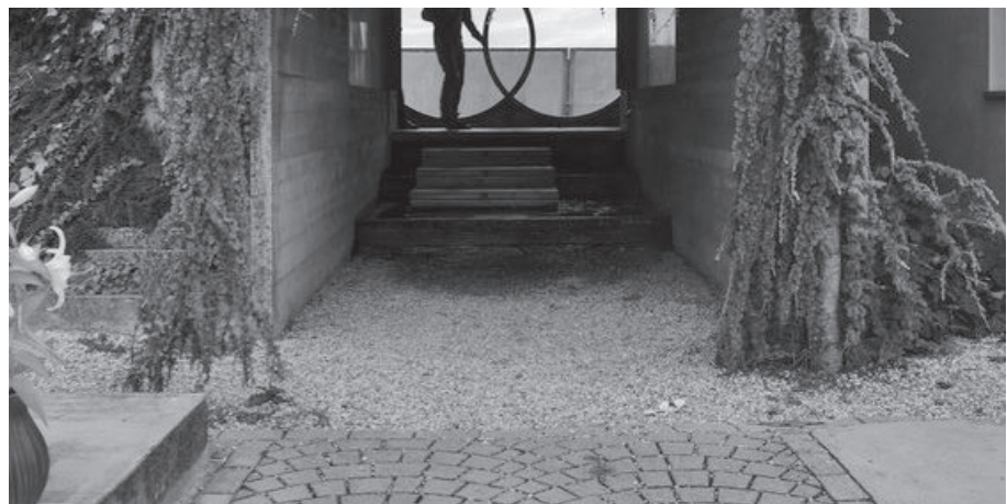
Fig. 51. Tumba Brion. Detalle del pavimento
