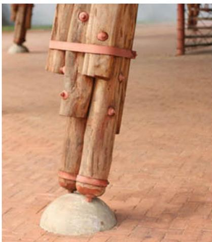
Fig. 4.56. Detalle del apoyo en el suelo.
