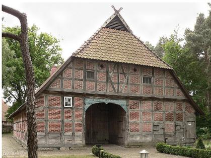
Fig. 3.46. Entramado alemán relleno con ladrillo.
