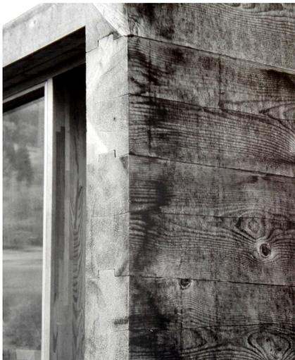
Fig. 4.48. Junta de la madera apilada.
