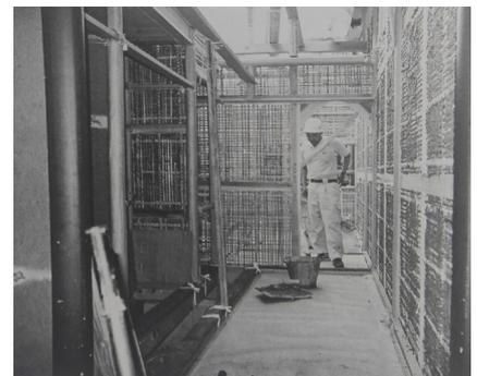
Fig. 3.21. Proceso de construcción de una vivienda tradicional japonesa.
