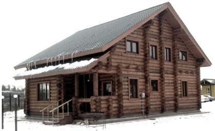
Fig. 3.39. Muro marcado con líneas verticales por el método de unión de troncos.
