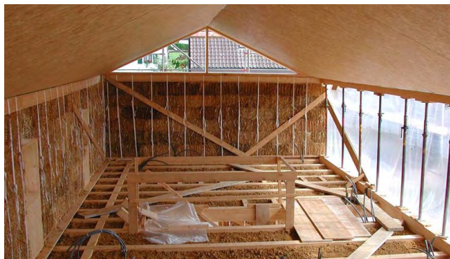
51-52-53-54 Casa Schmidlin en Walhen (2004) Sistema de muros de balas de paja portantes. Cubierta prefabricada con madera y balas de paja como relleno
