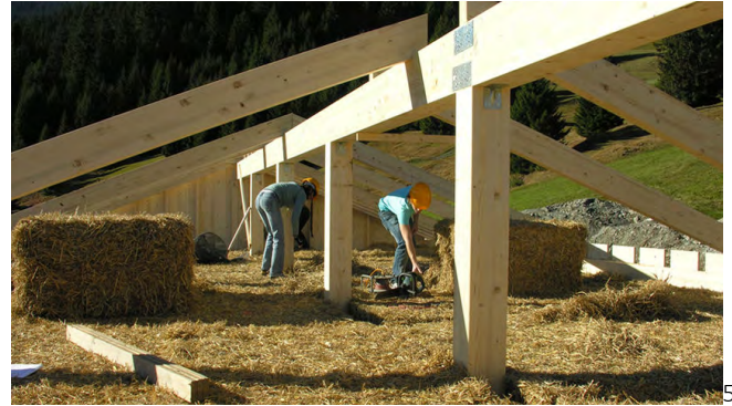
55-56-57-58-59 Casa Gliott en Laax (2011) Sistema híbrido. 58. Muro de balas de paja momento antes de ser cargado con el peso de la cubierta y entrar a colaborar con la estructura de madera.
