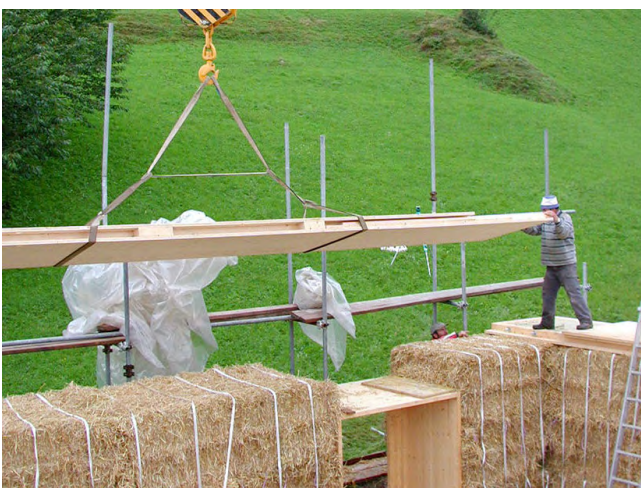
49. Casa Braun en Disentis (2003) Colocación del zuncho perimetral del muro de balas de paja portante.
