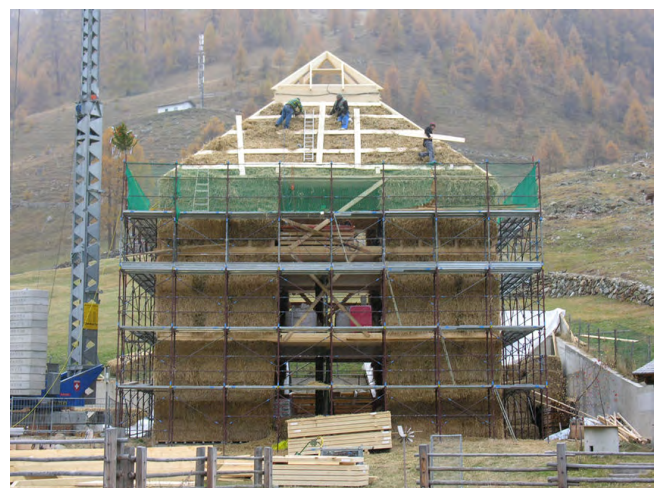
50. Casa Fliri en Graun (2007). Casa de cuatro alturas con estructura de muros de balas de paja portantes.
