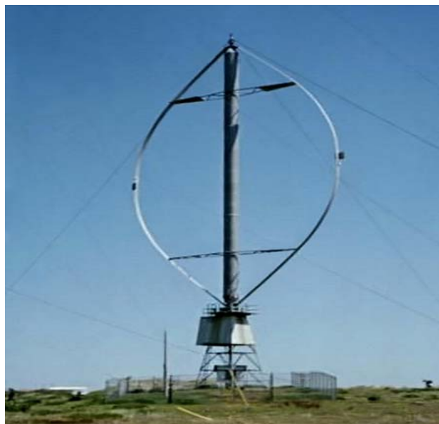
Figura 8: Aerogenerador Darrieus
