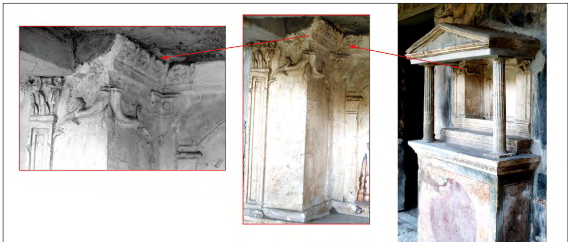
Figura 13. Larario de la Casa degli Amorini dorati (VI 16, 7-38) en Pompeya. Detalle de cómo la moldura recorre la estructura en la parte superior interna (Foto de N. Blanc).
