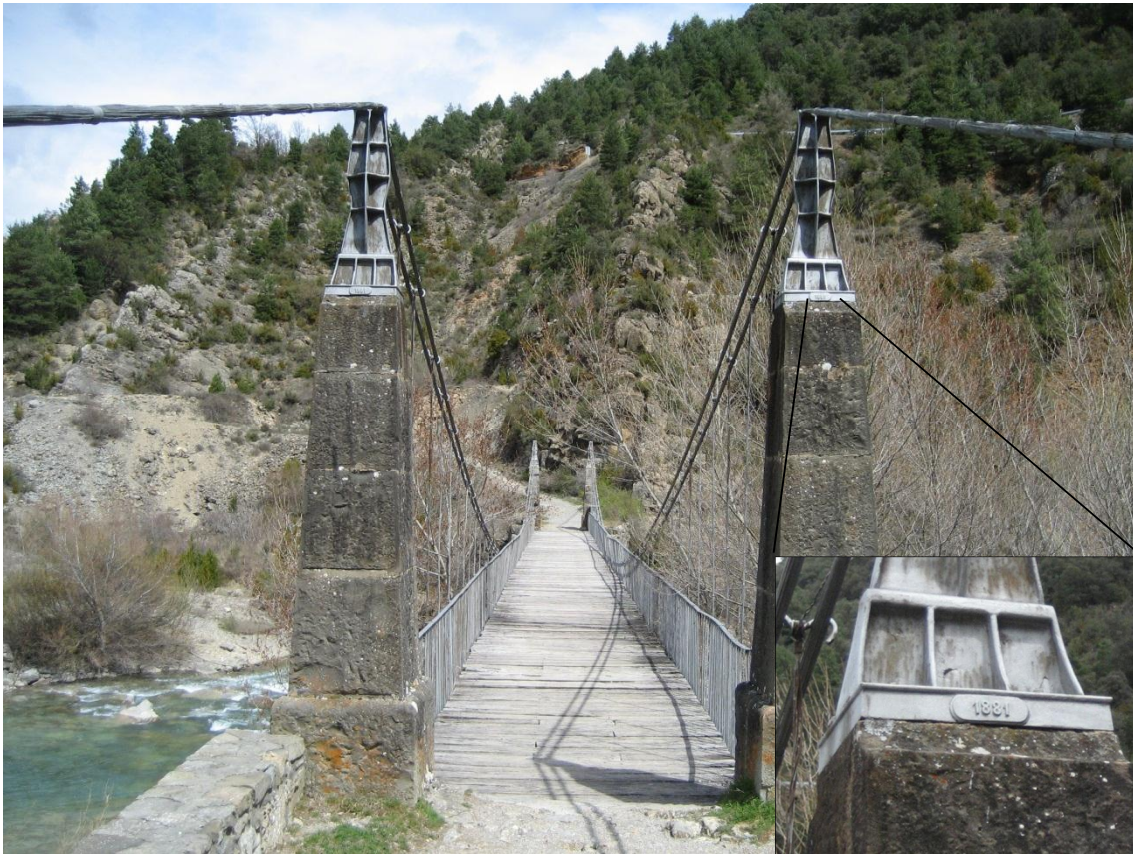
3-Puente colgante sobre el río Ara que data de 1881, en la Cerrada de Jánovas .
