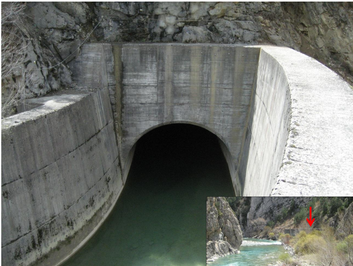
6-Salida del túnel de desvío aguas abajo de la Cerrada de Jánovas .
