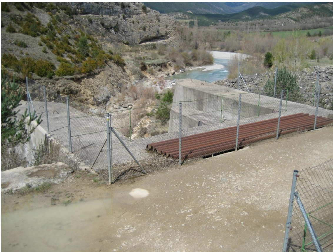
5-Cruce del túnel de desvío con el camino de Jánovas.
