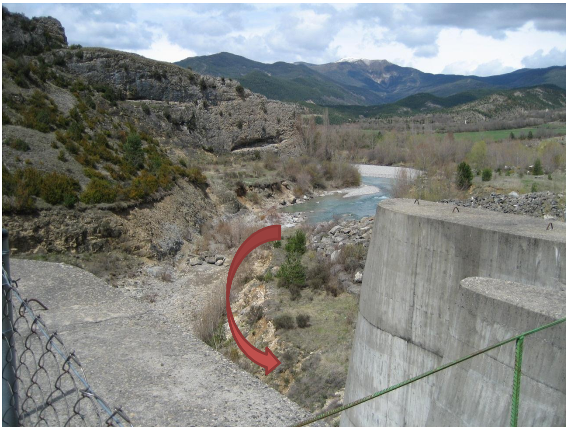
4-Obra de desvío del cauce para la construcción de la presa, entrada del túnel de desviación.
