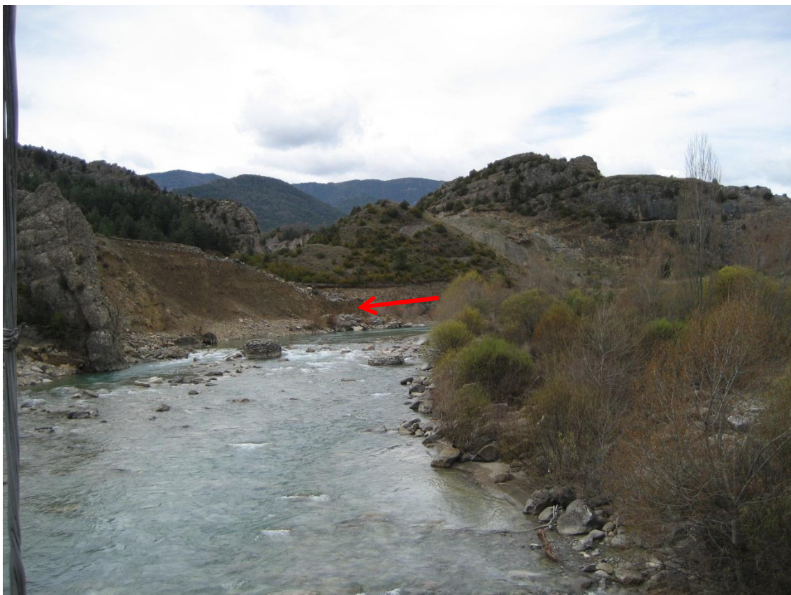
7-Cauce del Ara, al fondo se observa el cauce de derivación realizado para construir la presa.
