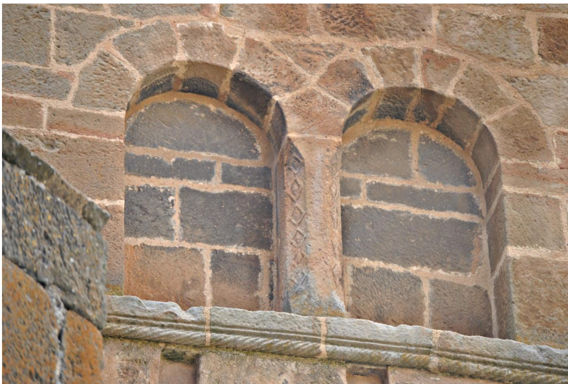
Ilustración 32: Iglesia de San Miguel Arcángel. Torre, arcos cegados piso 2.
