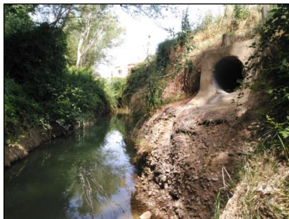
Foto 4: Desagüe del sistema de drenaje del tramo C Fuente: Elaboración propia
