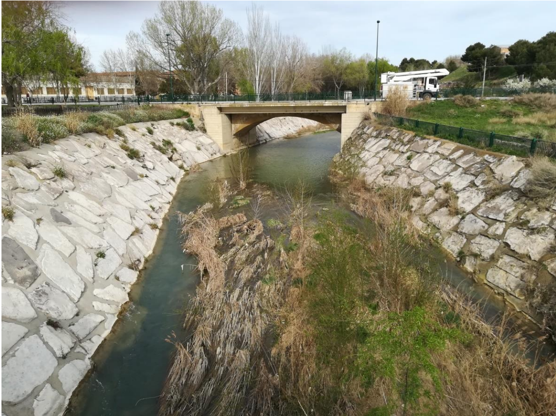
Figura 81. Tramo canalizado (muro de escollera) a la salida del Parque de Ejea. Elaboración propia.
