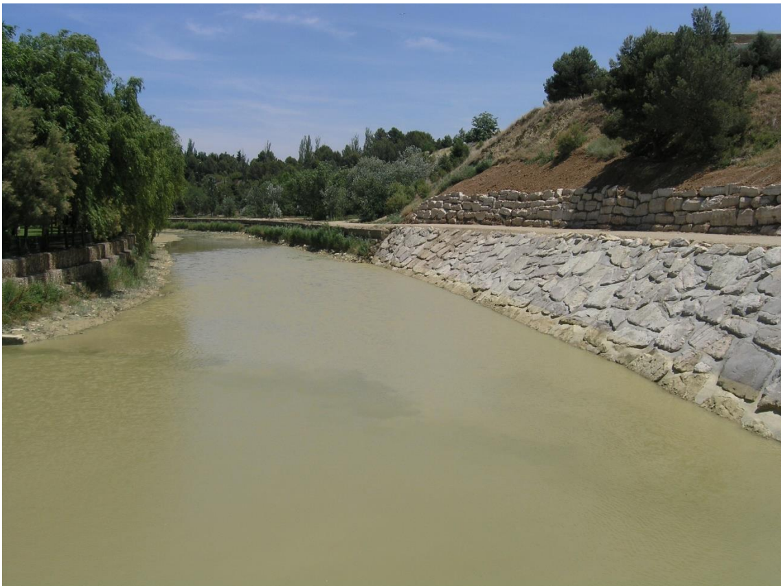
Figura 82. Zona protegida con gaviones (izquierda en la foto) y muro de escollera (derecha) en el Parque Central de Ejea de los Caballeros. Fuente: Alfredo Ollero.
