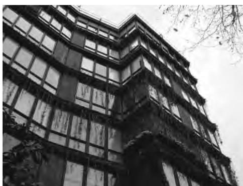
[F9] Edificio de viviendas en via Quadronno (Milán, 1960-62). Detalle de la textura de los paneles de madera Douglas en fachada. Fotografía: Carmen Diez
