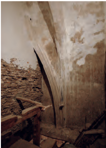
Fig. 5. Daroca (Zaragoza). Santo Domingo de Silos. Espacio de acceso al órgano. Vestigios de arco apuntado y de bóveda de crucería. Fotografía: Javier Ibáñez Fernández.
