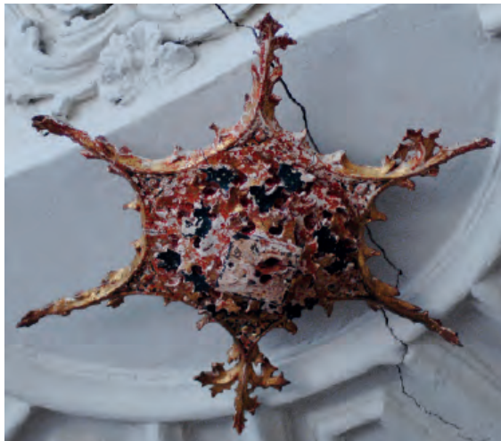
Fig. 6. Daroca (Zaragoza). Santo Domingo de Silos. Clave gótica de madera reutilizada en el sotacoro. Fotografía: Javier Ibáñez Fernández.
