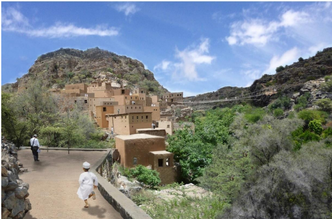
Fig.6 Vista del Asentamiento Norte. Puente de Acceso, pasos peatonales, terrazas y edificios rehabilitados.
