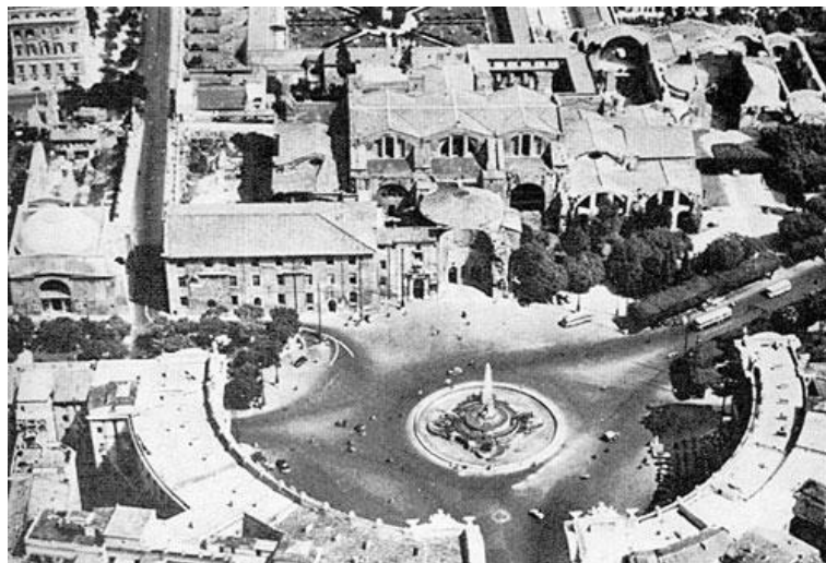
Figura 9. La antigua exedra de las Termas de Diocleciano transformada en Piazza della Repubblica.
