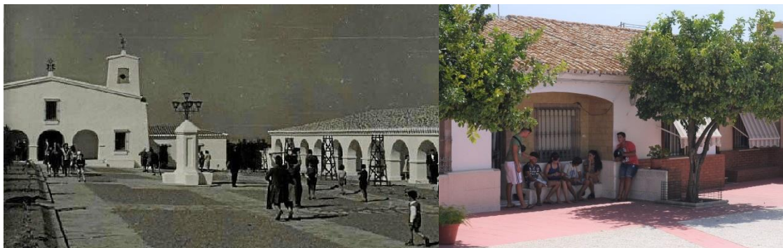
Figuras 15. Aldea Minas de Herrerías. Puebla de Guzmán (Huelva). Proyecto Alejandro Herrero. (AMH_FAHA, 1952). Figuras 16. (Dcha.). Porche de acceso con área de convivencia (conservada) en 50 Viviendas en Ayamonte. (Autores 2017).
