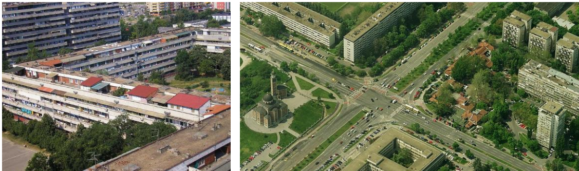
Figura 8. La complejidad postmoderna: a) una mini-aldea sobre el meandro (21, bien cultural bajo protección anterior); b) la esquina rural (1, bien cultural bajo protección anterior) y la iglesia serbo-bizantina (32).
