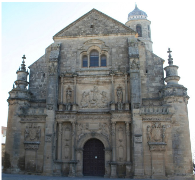
Figura 1.- Fachada oeste de la iglesia de El Salvador (Úbeda, Jaén)
