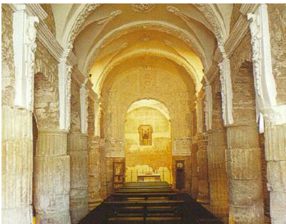
Fig. 62: Ermita de Nuestra Señora de los Arcos Ubicada a 4 km de Tricio. Corresponde a un edificio en el que se emplearon en el siglo IX en su construcción los tambores, basas y capiteles a pertenecientes a un edificio público de gran entidad, Posiblemente el templo del foro. (Imágenes: C.
