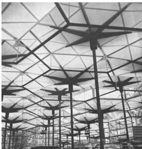
Fig. 23. Detalle de los “paraguas” y de los cerramientos en vidrio. Imagen publicada en Informes de la Construcción , n.106, diciembre 1958.
