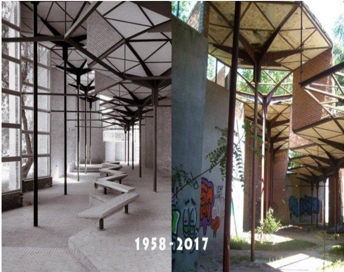
Fig. 64. Estado actual del Pabellón de España para la Exposición Internacional de Bruselas 1958 en la Casa de Campo de Madrid. Fuente: artículo del diario digital El Confidencial , 2017.
