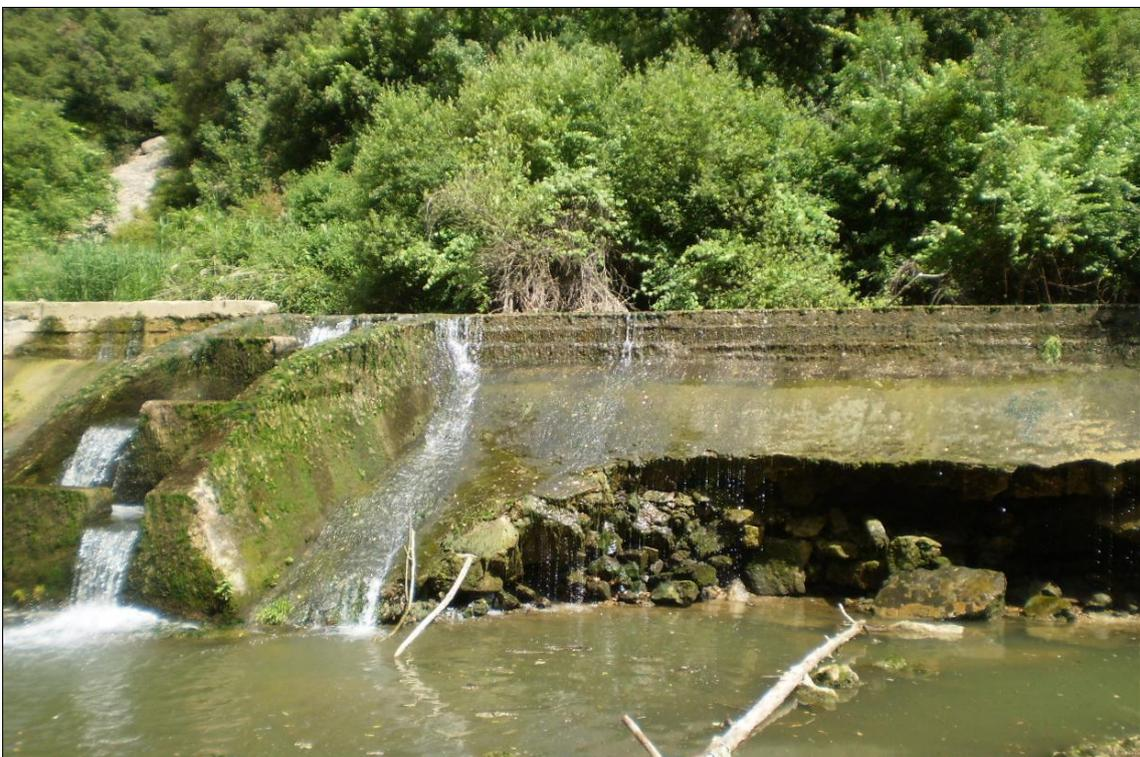
**Foto 6:** desperfectos en el azud del *Molino de Arquijas* (*Central de Zúñiga*). Coordenadas UTM (557341 , 4725210). Tomada por el autor el 03/07/18, en el paraje “El Carrascal” de Zúñiga (Navarra).
