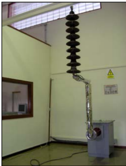
Fig. 20 Terminal de alta tensión aislado
