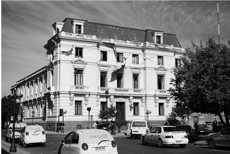
FIG. 24 Edificio con estructura de muros colapsada
