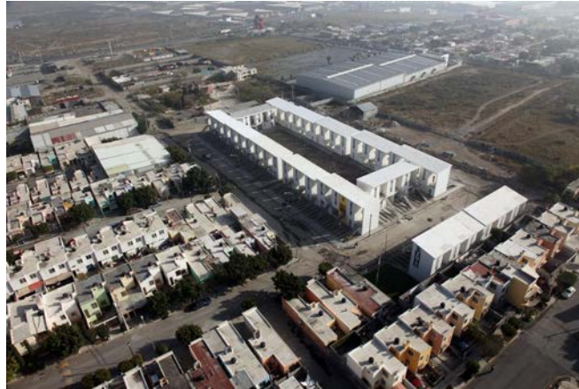
FIG 80 Conjunto en el centro de la ciudad
