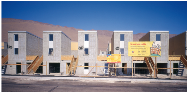
FIG. 03 Viviendas Quinta Monroy. Diciembre 2004
