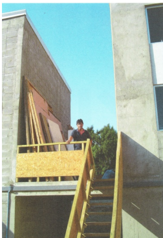
FIG. 49 Trabajos de ampliación en la Quinta Monroy
