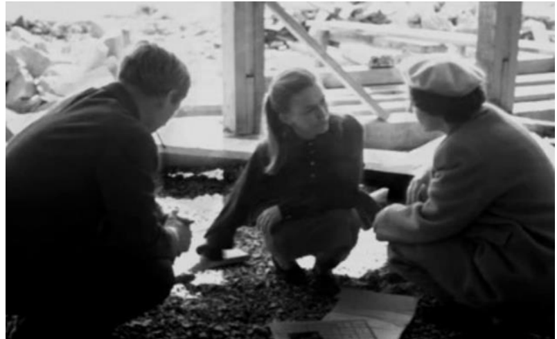
[Figura 45] Anne Tyng junto a Louis Kahn durante la construcción de la Weiss House
