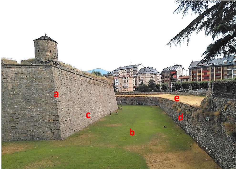
Figura 21. Esquina de un baluarte (a), foso (b), escarpa (c), contraescarpa (d) y camino cubierto (e) de la ciudadela de Jaca (foto del autor)
