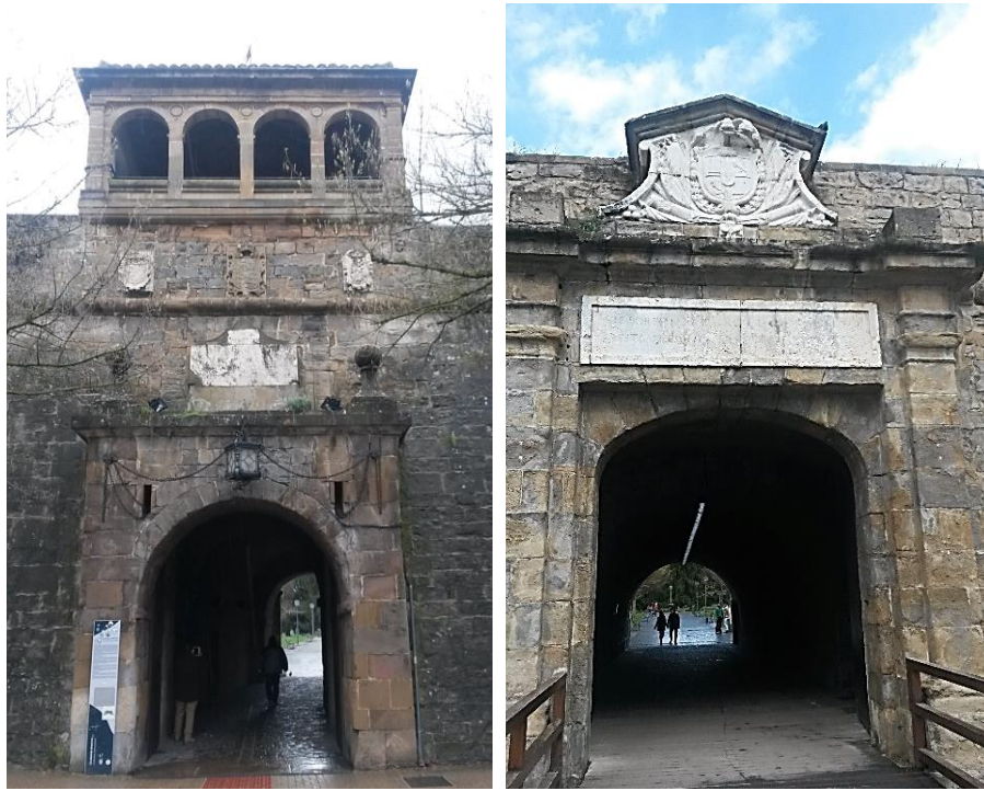
Figura 14. Izda.: puerta principal de la ciudadela de Pamplona. Dcha.: puerta del Socorro (fotos del autor).
