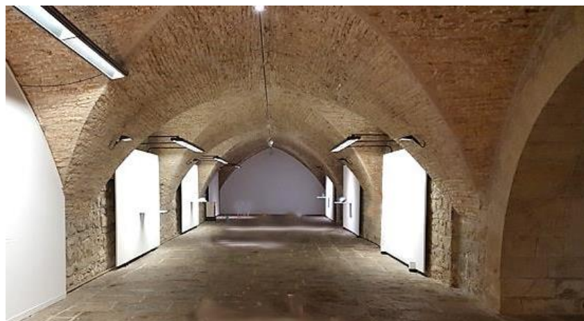
Figura 17. Exterior e interior del actual polvorín de la ciudadela de Pamplona (fotos del autor).
