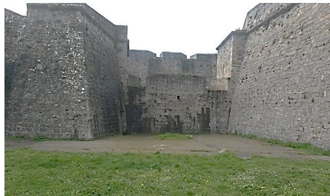
Figura 12. Arriba: vista aérea de una casamata (a) y orejón (b) del baluarte de Santa María de la ciudadel de Pamplona. Fuente: Google Earth [fecha de consulta 10-I-2018]. Abajo: vista de la casamata desde el foso (foto del autor).
