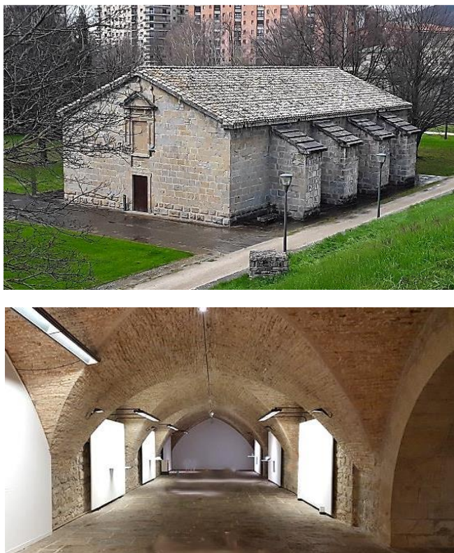
Figura 17. Exterior e interior del actual polvorín de la ciudadela de Pamplona (fotos del autor).
