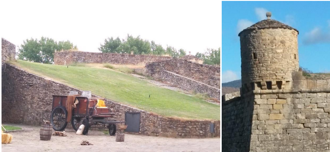
Figura 24. Izda.: terraplén de acceso al baluarte de Santa Orosia de la ciudadel de Jaca. Dcha.: garita y cordón (fotos del autor).
