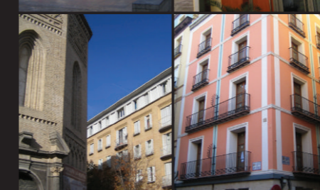
Viviendas para alquiler y venta
