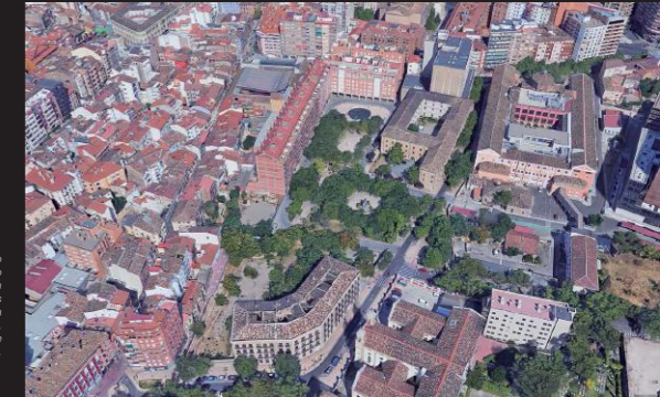
Actuación en el Cuartel de Sangenis o de Pontoneros: rehabilitación del antiguo edificio del Regimiento de Infantería Agustín Sanz, arquitecto, 1920) para dependencias municipales, urbanización de la plaza José María Forqué, edificios de viviendas, rehabilitación del edificio municipal de viviendas (1880-1889), hoy todavía sin uso.
