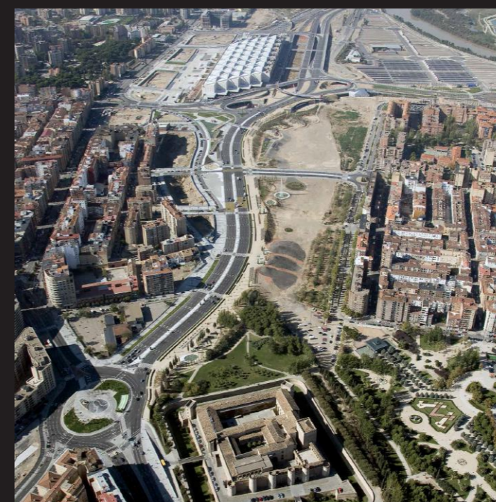
Obras de urbanización sobre las vías ferroviarias
