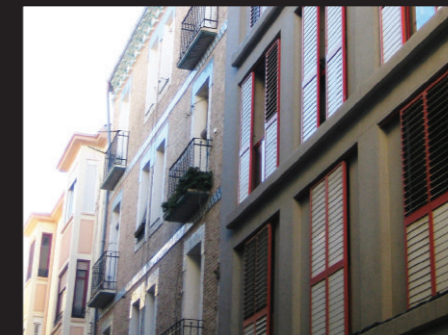
Viviendas públicas en alquiler, c/Boggiro, 1990
