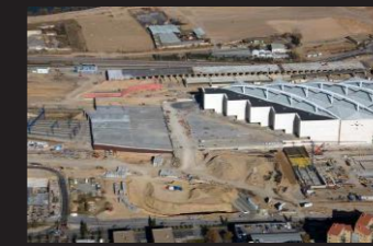
Cubrimiento de vías lado Madrid
