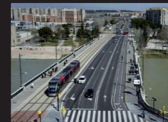
El puente de San Roque es la principal conexión del centro de la ciudad con el ACTUR Rey Fernando.
