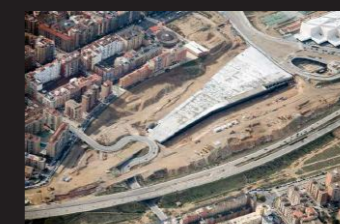
Cubrimiento de vías lado Barcelona
