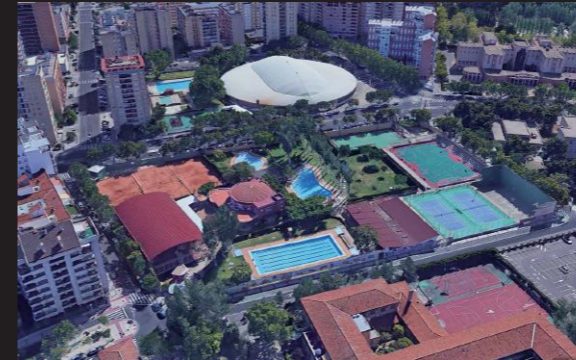
Actuación en las instalaciones de Sociedad Hípica Zaragozaana, reconvertidas en Centro Deportivo Municipal Gran Vía.
