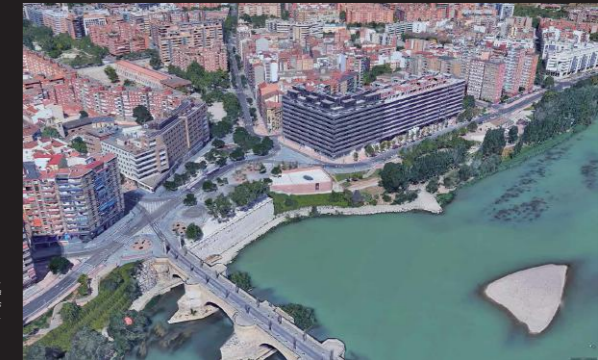
Actuación en el Cuartel de San Lázaro, transformado en zona peatonal, mirador hacia las riberas del Ebro, restos arqueológicos visibles y nueva fachada residencial.
