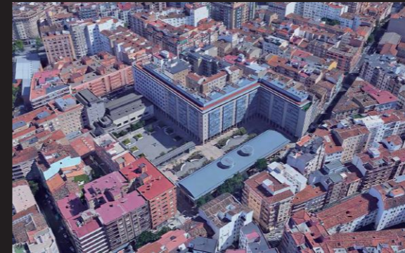
Actuación en el Cuartel de Hernán Cortés: Biblioteca de Aragón, viviendas, aparcamiento subterráneo, Junta de Distrito y centro de convivencia para mayores.
