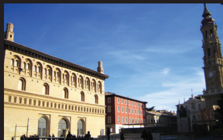
Remodelación de la Plaza del Pilar
