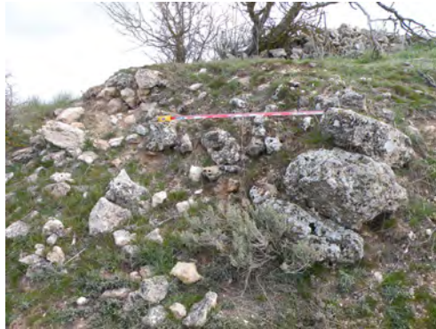
Figura 9. Aspecto actual de la muralla seccionada.
