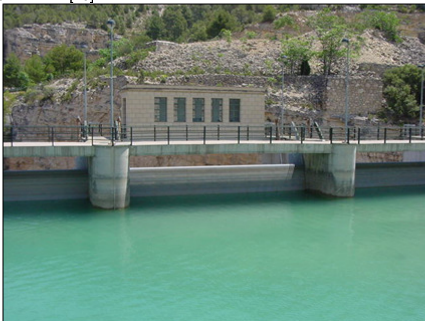
Figura 4: Vista general del aliviadero desde aguas arriba
