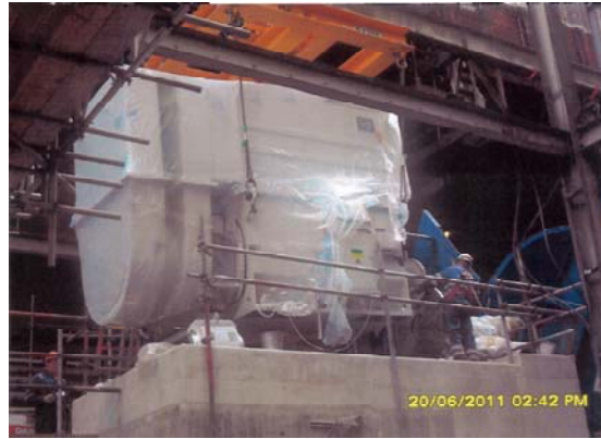
Figura 21 Nuevo motor del ventilador de tiro inducido instalado
