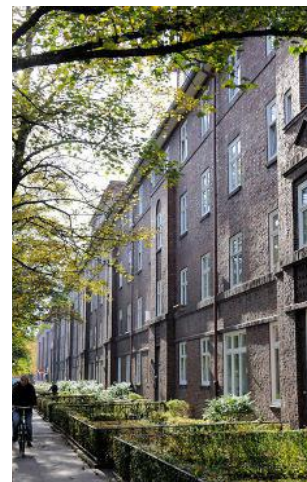
Fig. 36- Vista exterior desde calle rodada
