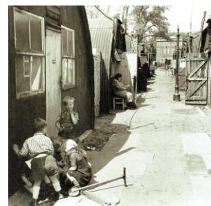
Fig. 48- Vista exterior de los barracones de emergencia
