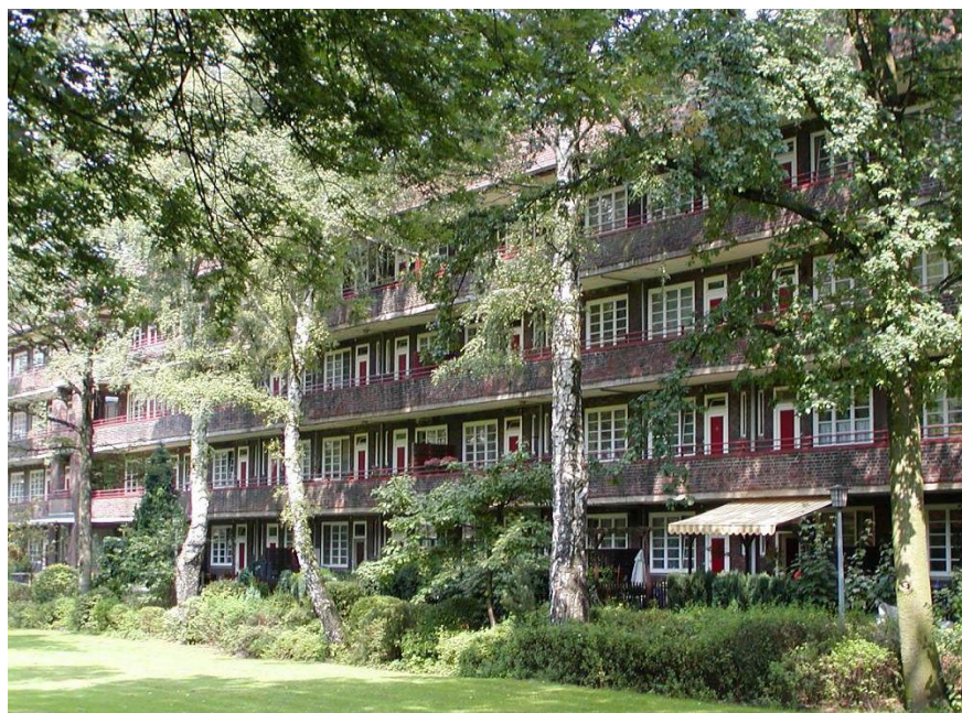
Fig. 37- Patio interior privado de los Laubengänger de Brüder Frank
