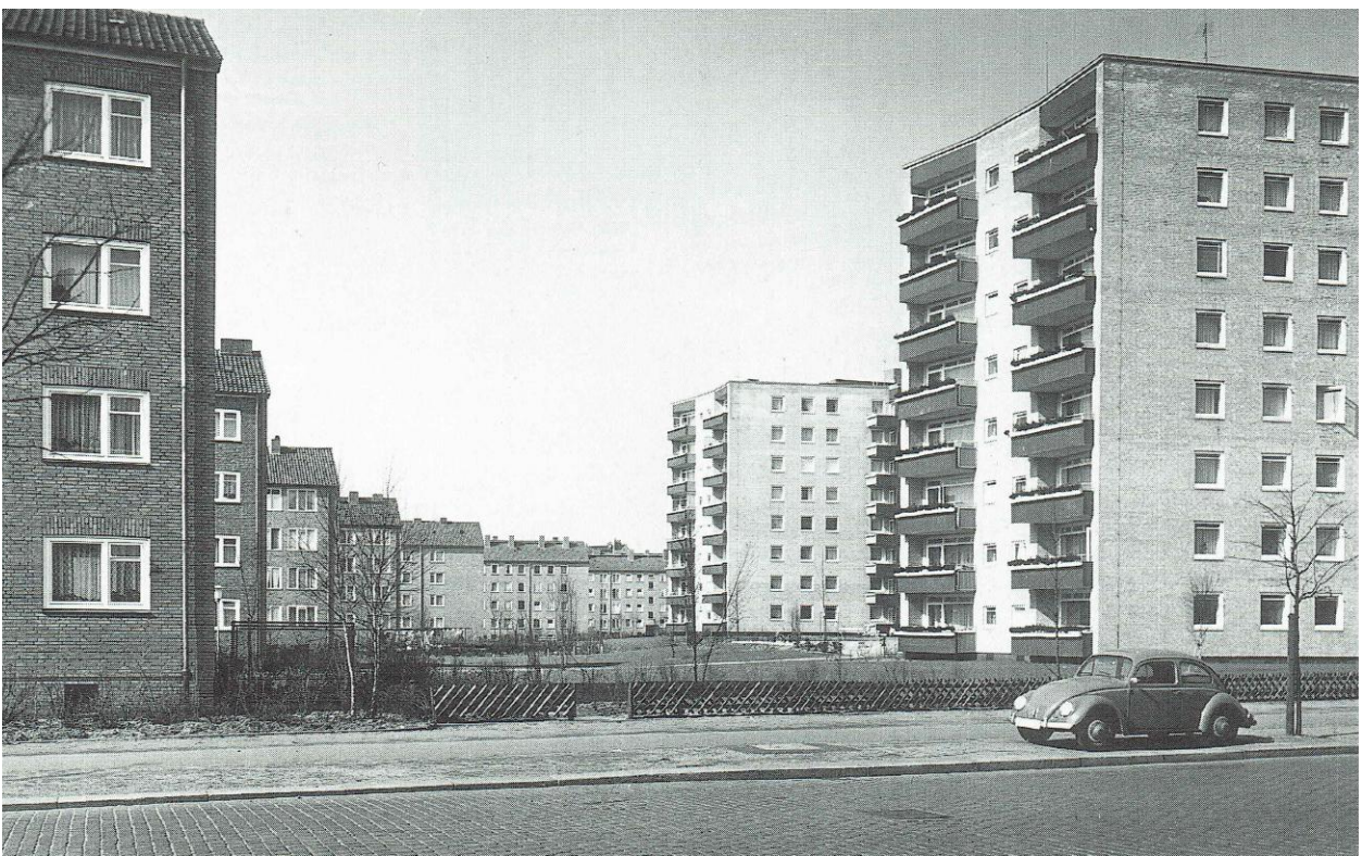
Fig. 68- Vista del conjunto desde las vías
