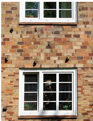
Fig. 29- Fachada de ladrillo ocre de Oelsner
