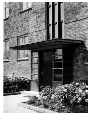
Fig. 45- Verticalidad de la escalera y acceso con un vuelo que protege de las inclemencias
