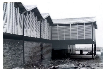
Fig. 22: Exterior. Zona de entrada a la piscina
