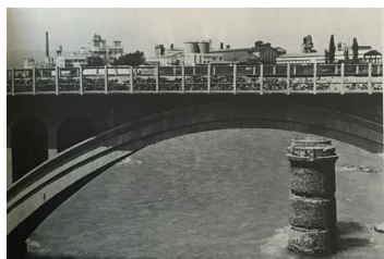
Fig. 15: Instalación de la empresa Hidro-Nitro en la ribera del río Cinca.
