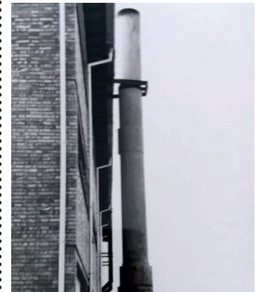
Fig. 31: Aparecen en sus fachadas instalaciones vistas que le dan un carácter mucho más fabril.
