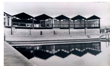
Fig. 21: Equipamiento aún en construcción visto desde la piscina
