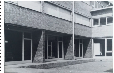
Fig. 30: La fachada muestra la marcada presencia de la estructura y en ella aparecen aperturas horizontales.
