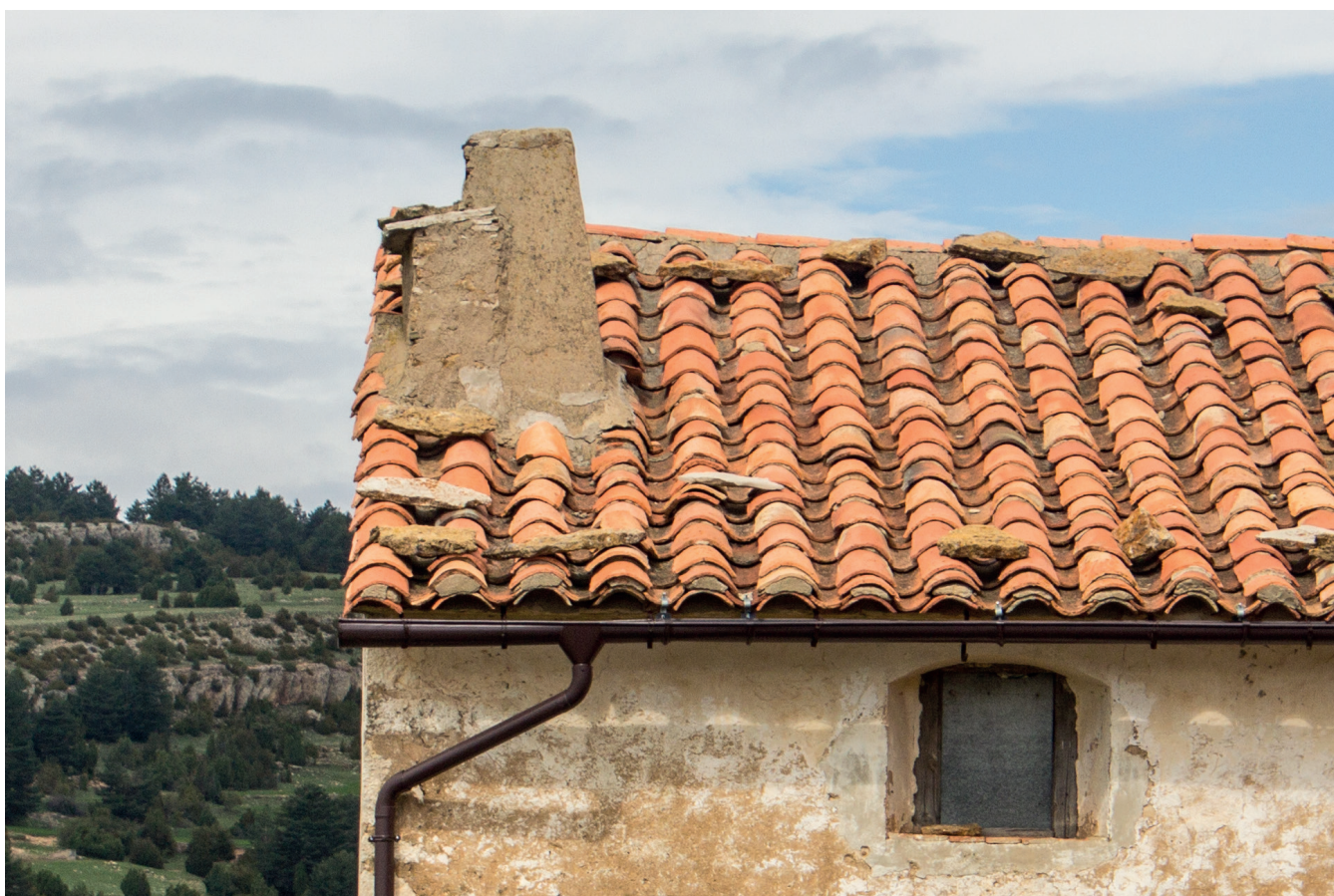
[Fig. 42 *_Detalle de la chimenea con refuerzo, Masía El Rallo]
