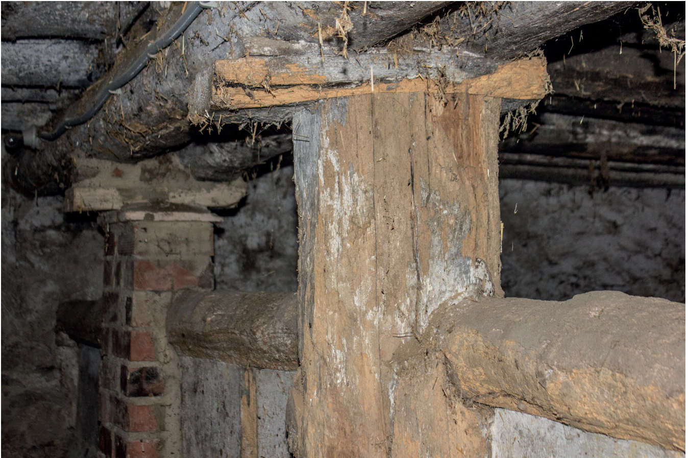
[Fig. 35 * _Detalle de refuerzo de viga de madera con pilar de madera]
