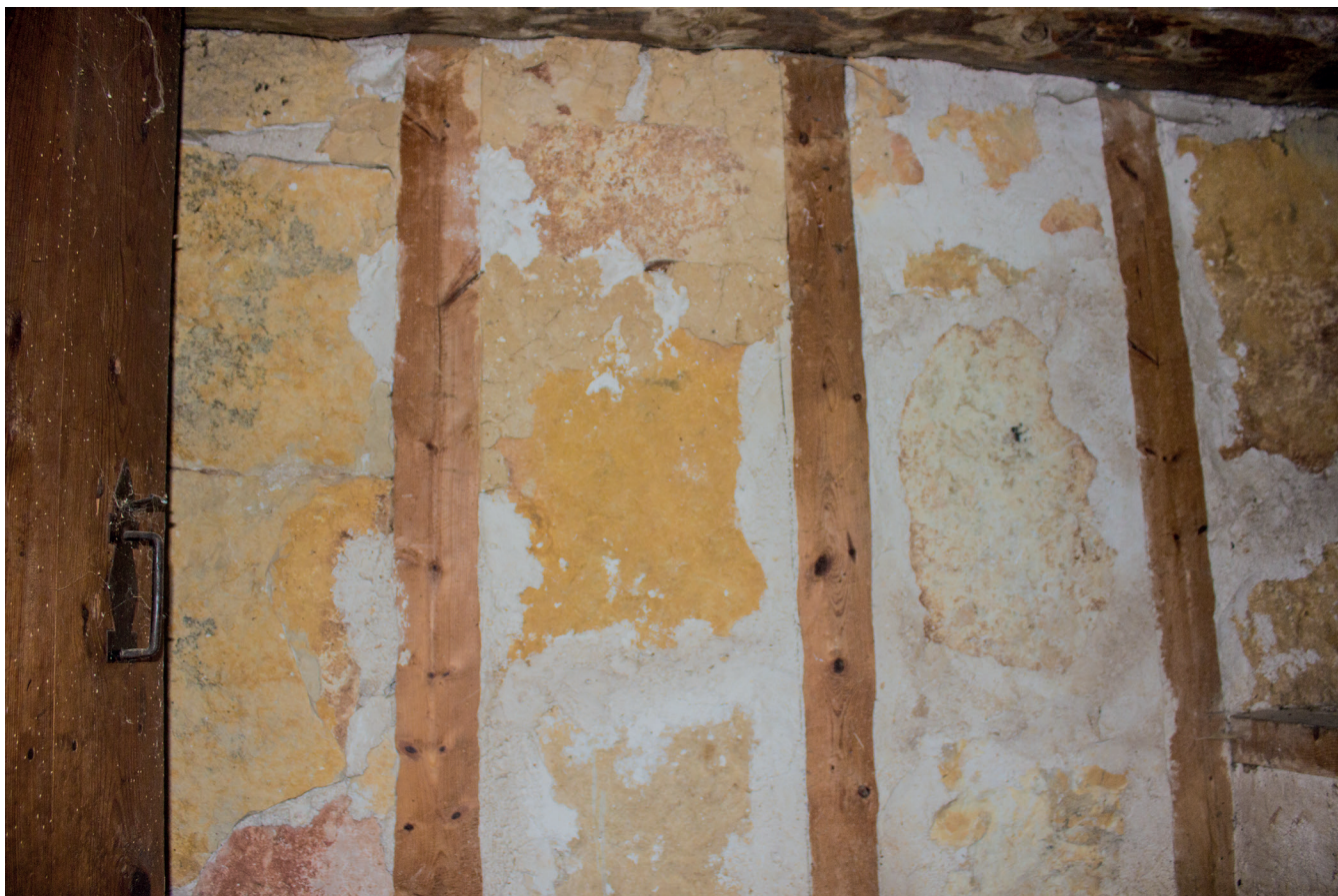
[Fig. 37 *_Detalle de tabiquería interior de losas de piedra y madera]
