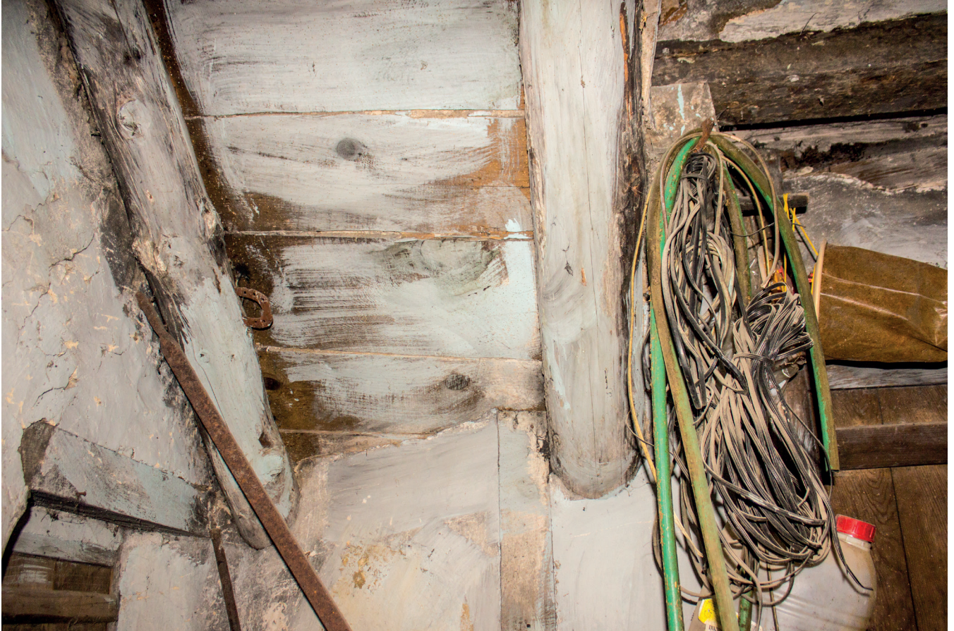
[Fig. 39 * _Parte inferior de escalera con tabloncillos de madera sobre vigas de madera]
