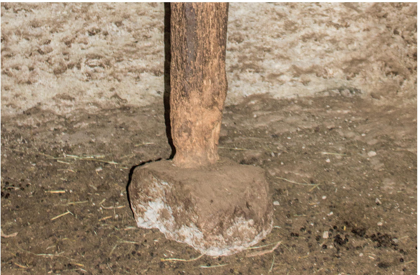
[Fig. 36 * _Apoyo de pilar de madera sobre piedra caliza para proteger de humedades y podredumbre por el uso de la cuadra]
