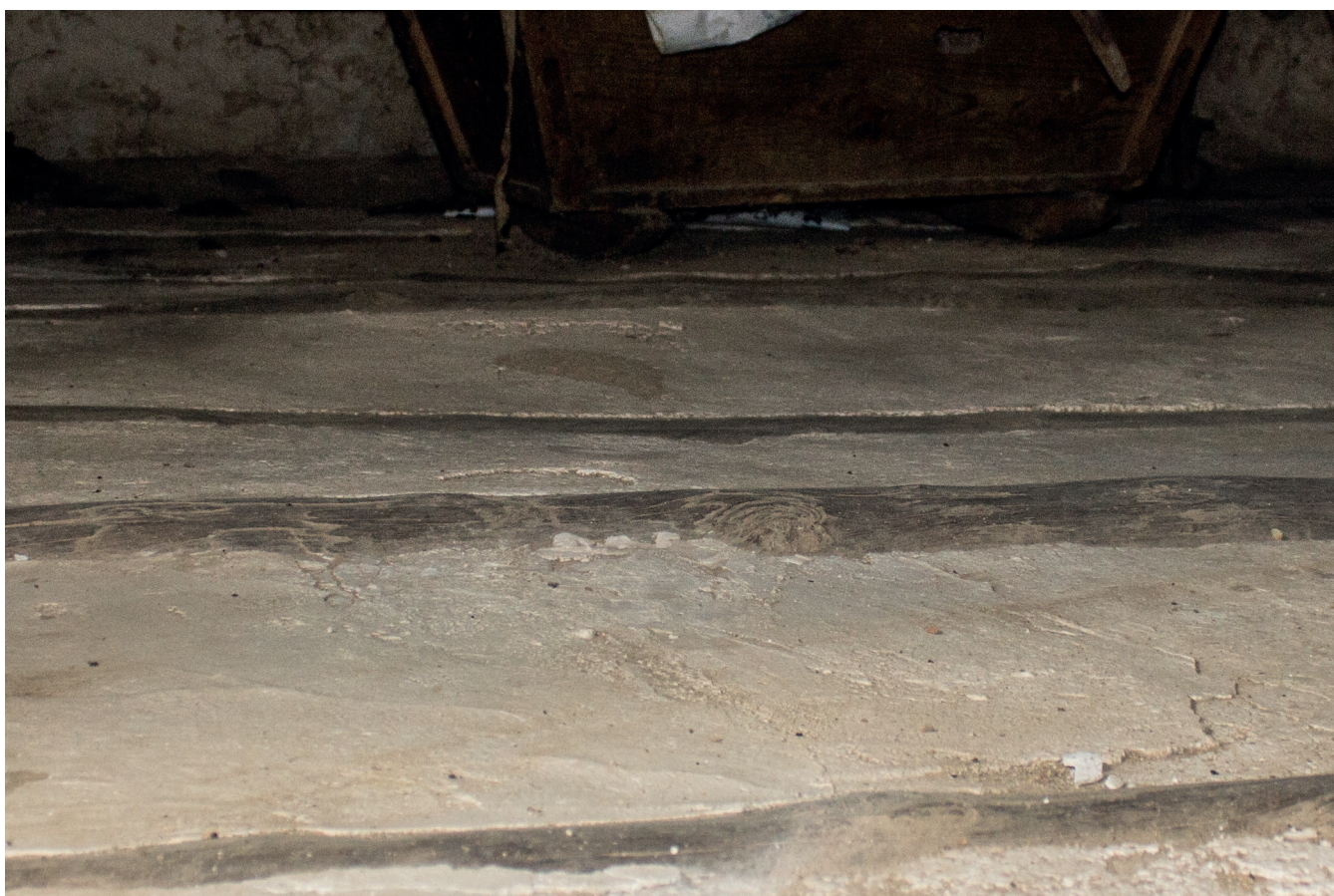
[Fig. 38 *_Detalle de suelo de yeso entre vigas de madera]
