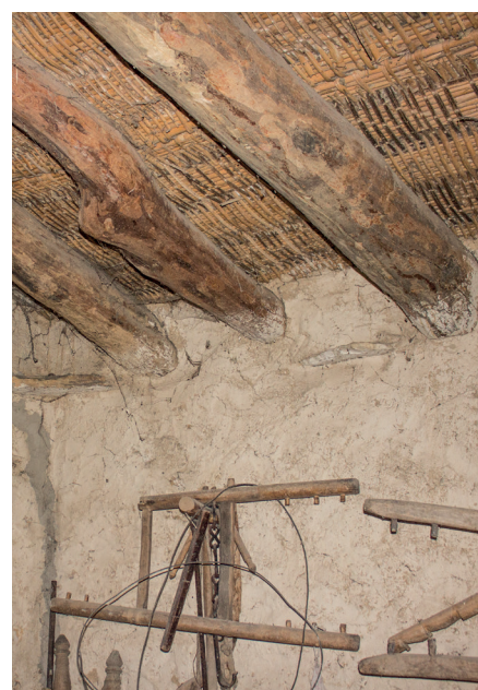
[Fig. 25 *_Detalle del tejado, cañizo]
