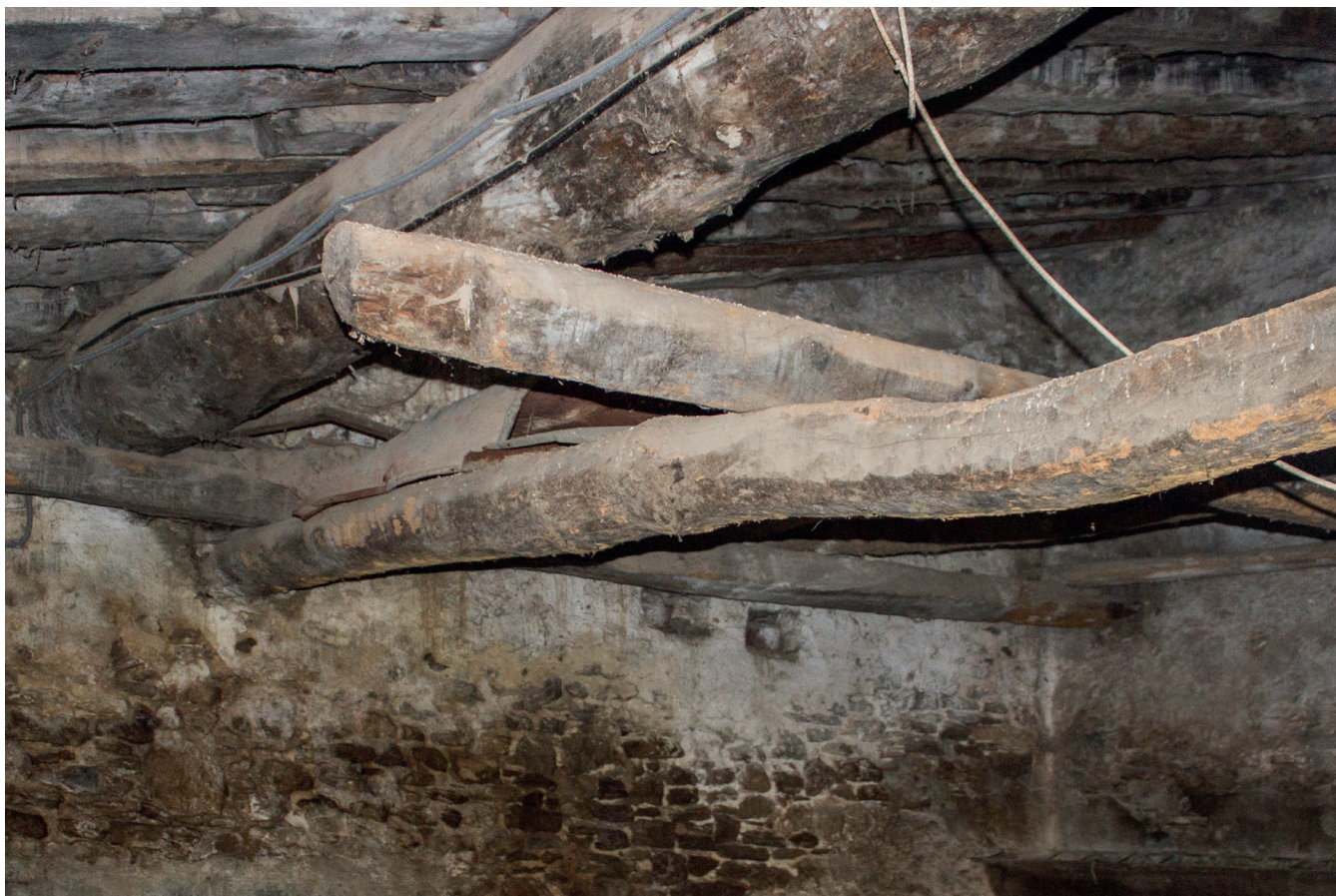
[Fig. 33 *_Detalle de encuentro de vigas de madera en planta baja que soporta el forjado de la vivienda]
