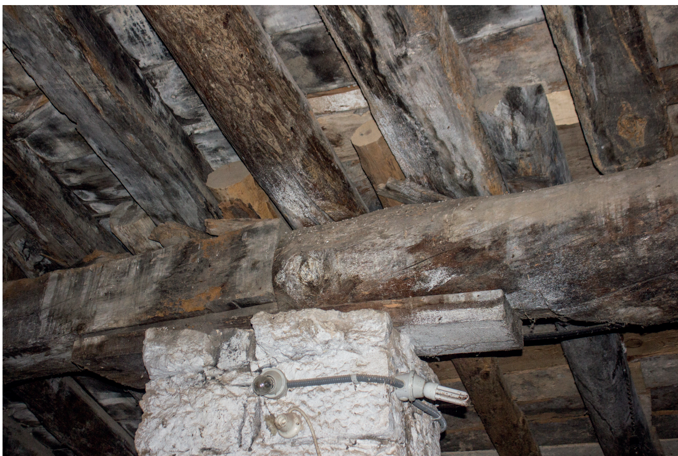
[Fig. 34 *_Detalle de encuentro de vigas de madera con pilar de mampostería en planta baja que soporta el forjado de la vivienda]
