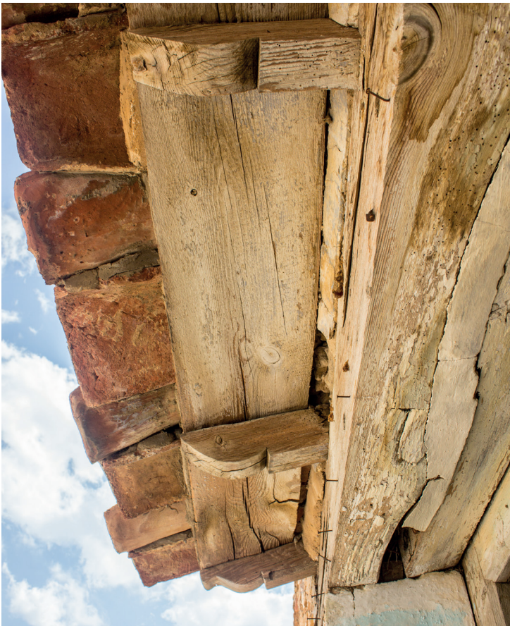
[Fig. 40 * _Solución de alero de madera con tejado de tejas]
