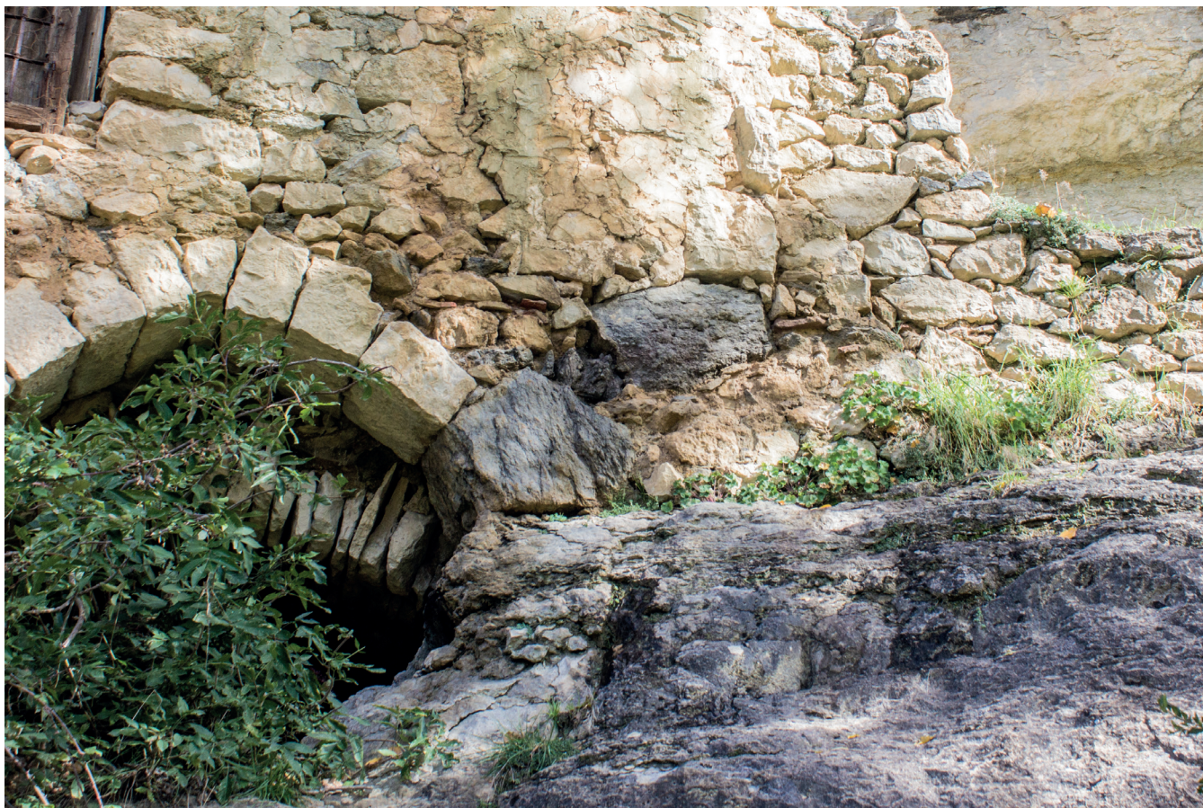
[Fig. 41 *_Detalle de cimentación sobre roca, Masía Molino Alto]
