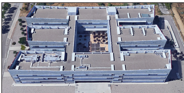
Figura 62 – Edificio del I3A en Zaragoza, España (imagen extraída de Google Maps).
