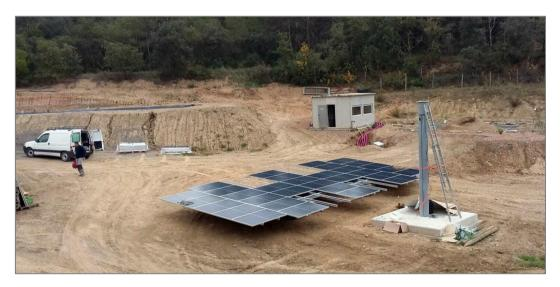
Figura 10. Fase de montaje del seguidor solar.
