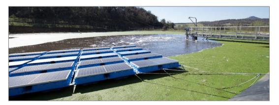
Figura 12.Balsa con paneles flotantes y aireador 2 en marcha.
