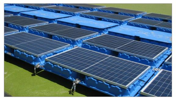
Figura 8. Vista cercana del conjunto de paneles flotantes.
