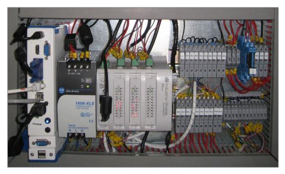
Figura 15.. De izquierda a derecha: Ordenador de control, fuente de alimentación, controlador lógico programable basado en Arduino.
