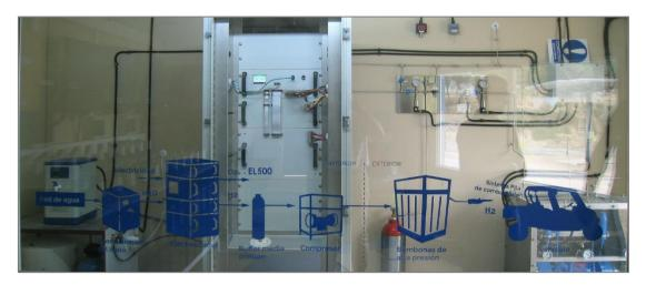
Figura 17. La zona de producción de hidrógeno. De izquierda a derecha: depurador de agua, electrolizador alcalino, depósito buffer a 20 bar, compresor hasta 200 bar.
