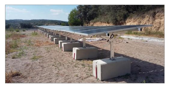
Figura 9. Conjunto de paneles sobre suelo, antes de su conexión.
