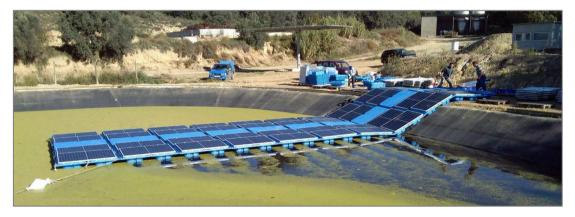
Figura 7. Fase de montaje del conjunto flotante de paneles fotovoltaicos.
